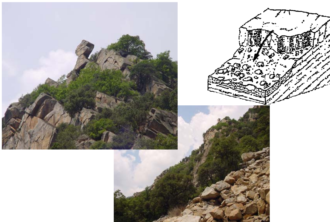
Figura 6.16. Desprendimientos de bloques rocosos en un sector de Andorra la Vella.
