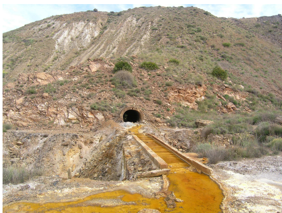
Figura 1.1 Drenaje ácido de mina. Se aprecian los ocre y eflorescencias salinas generadas a partir de este agua (Túnel Lilian; Sierra de Cartagena-La Unión)
