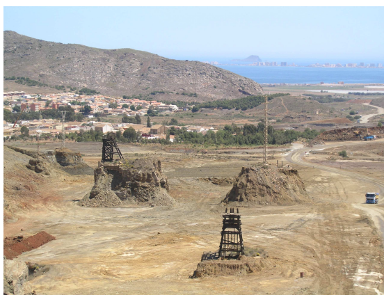
Figura 2.18 Eliminación de residuos al sur del término municipal del Llano del Beal (Mayo 2005). Obsérvese en que situación se han dejado los castilletes de antiguas explotaciones mineras
