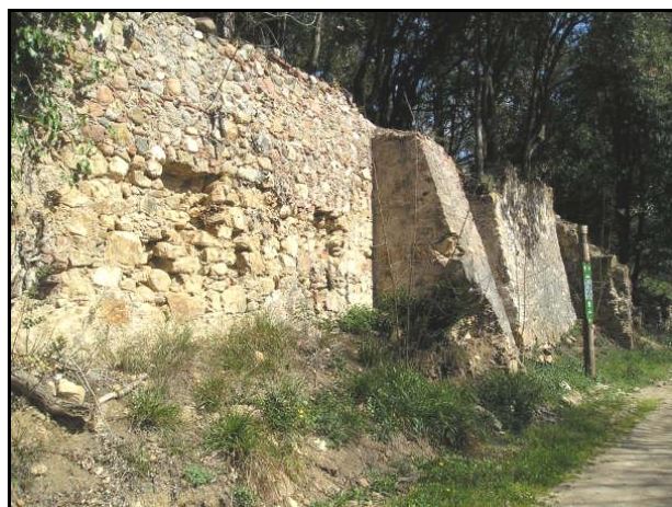
Figura 1-5. Murs de la bassa de la farga d'Hostalric
