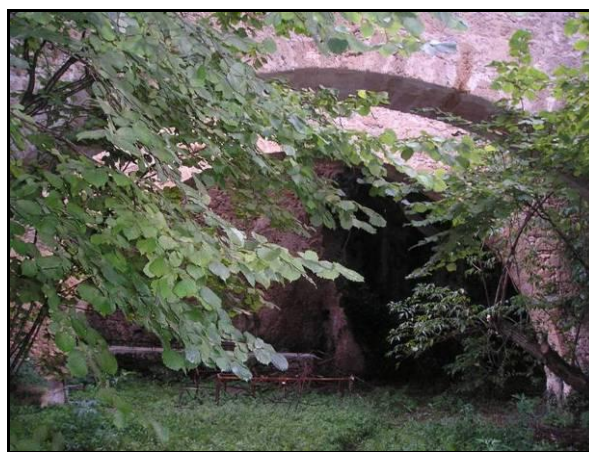
Figura 1-4. Vista de l'interior de l'edifici des de la porta d'entrada. Foto: Eva Garcia, 2008.
