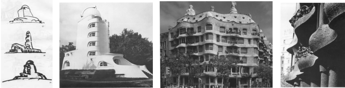
Croquis y vista de la Torre Einstein de Mendelson en Postdam, Alemania. Vista y detalle de la fachada de la casa Milá (La Pedrera) de A. Gaudí en Barcelona.
