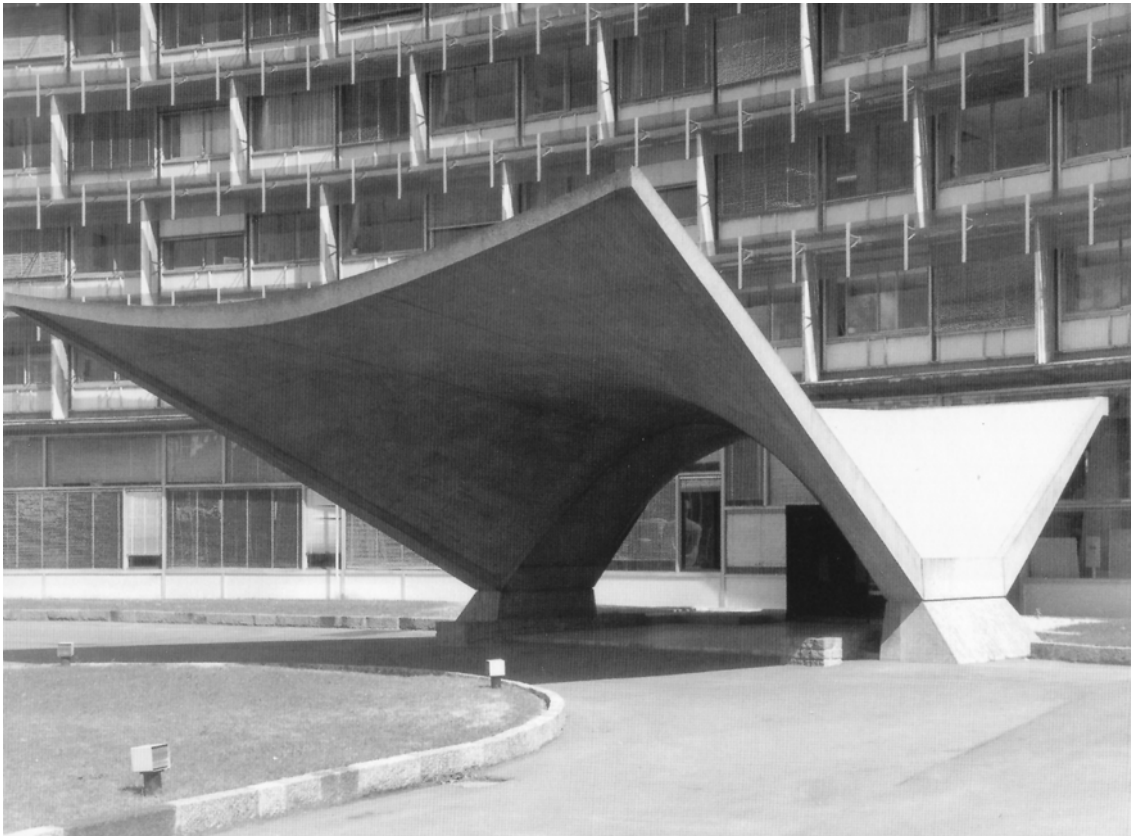
Vista de la marquesina de acceso al Secretariado.
