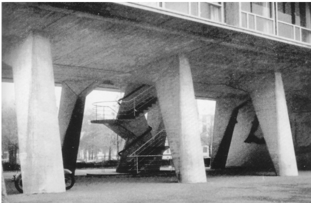
Pilares y forjado de soporte del edificio del secretariado.
