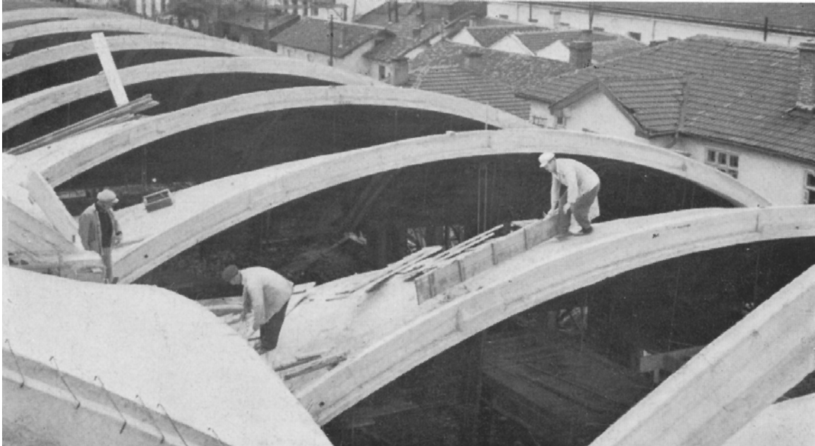
Operarios acabando la cara superior de las conchas.
