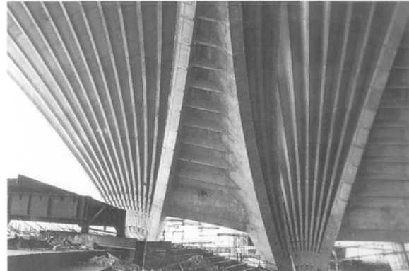
Esquema de reparto de las costillas según meridianos. Vista de la cubierta por debajo.
