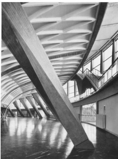
Vista interior de la sala anular bajo las gradas con los pilares inclinados.
