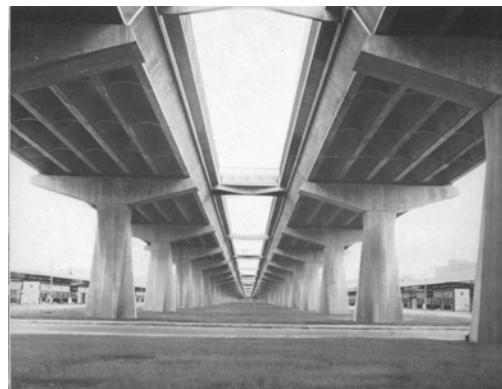
Seis grandes vigas se apoyan sobre los pórticos en forma de T. La imagen unitaria se consigue porque todos los pórticos son iguales.
