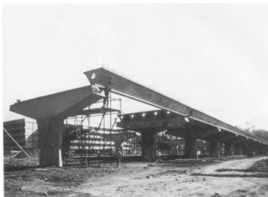
Seis grandes vigas se apoyan sobre los pórticos en forma de T. La imagen unitaria se consigue porque todos los pórticos son iguales.
