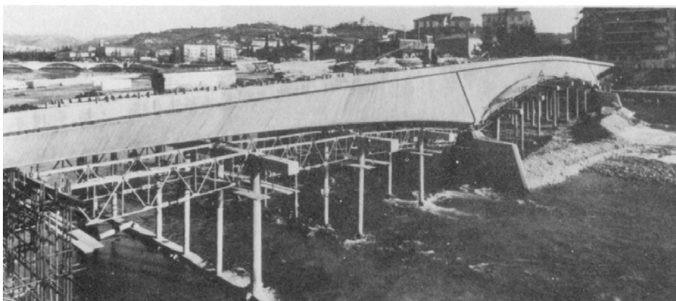
Vista del puente durante la construcción.
