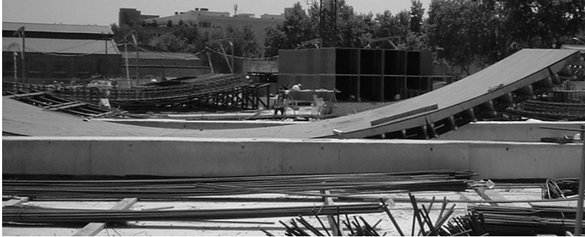
Una de las placas del encofrado.
