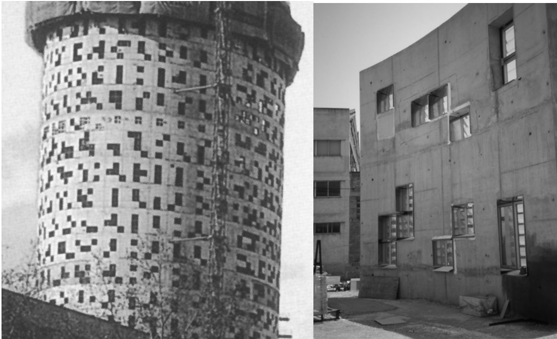
Vista de la torre durante la construcción del muro donde se ve diferentes combinaciones de ventanas. Vista del prototipo.
