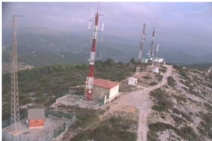
Imatge 115. Centre de Telecomunicacions de Sant Pere, Sant Pere de Ribes (Garraf). Centres dispersos amb torres de diversa altura. Fotografia de l'autor. 20/05/1997.
