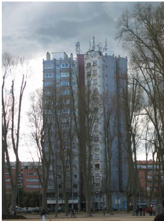
Imatge 85. Instal·lació de casetes, màstils, satèl·lits i antenes en la coberta d'un edifici
