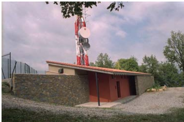
Imatge 107. Centre de Telecomunicacions de Vall de Bianya. Terme municipal de Vall de Bianya (Garrotxa). Centre integrat amb torre de 40,00 m. Fotografia de l'autor. 18/06/1998.
