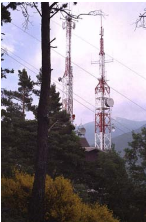
Imatge 113. Centre de Telecomunicacions de Ribes de Freser, Ribes de Freser (Ripollès). Centre mitjà de quatre sales a dos nivells amb torre de 27,00 m. Fotografia de l'autor. 29/09/1996.
