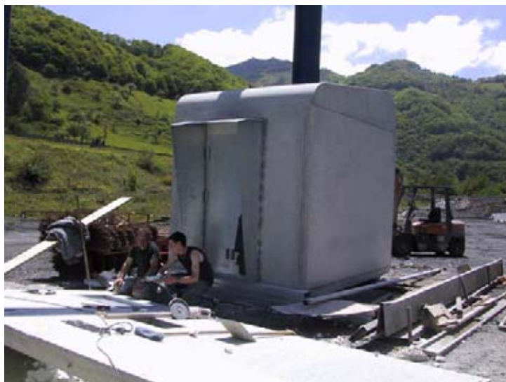
Imatge 66. Primer prototipus de caseta prefabricada de formigó Model Oval, a la campa
