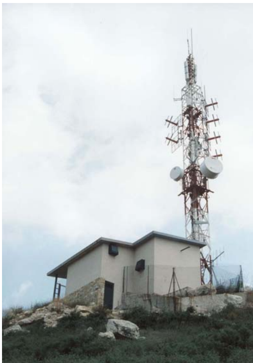
Imatge 24. Centre de Telecomunicacions de Montblanc, ubicat al terme municipal de Figuerola del Camp (Alt Camp). Típica instal·lació on hi ha col·locades les antenes de difusió de televisió analògica, al cap de munt de la torre, i les de difusió de ràdio analògic, a mitja altura. Fotografia de l'autor. 30/10/2000.
