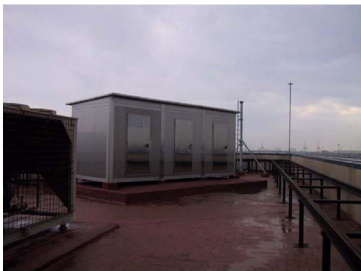
Imatge 72. Tipologia urbana prefabricada. Model desmuntable en alumini. Prototipus desenvolupat per Mundoforma i Tradia, ubicat al carrer Motors, núm. 392, L'Hospitalet de Llobregat (Barcelonès). Fotografia de l'autor. 15/10/2000.
