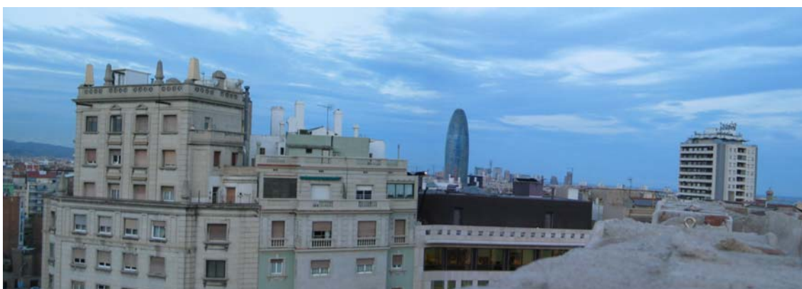
Imatge 120. Imatge on s'observen tres exemples diferents en la manera de resoldre la integració de les telecomunicacions, a la ciutat de Barcelona (Barcelonès). A l'esquerra un edifici situat a la cruïlla dels carrers Marina i Consell de Cent, amb una imitació, només ben
