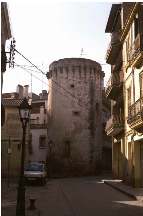
Imatge 8. Tipus torre de defensa. Torre del carrer d'Avall. Arenys de Munt (Maresme). Dita també de Can Llobet. Situada dins del nucli urbà. És de planta rodona, amb troneres i restes de la corsera. Data de l'any 1560. Correspon al grup de torres de defensa. Fotografia de l'autor. 03/05/1995.
