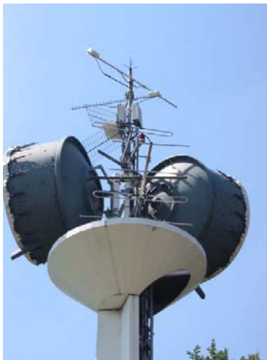
Imatge 109. Centre de Telecomunicacions de Sant Pau de Segúries. Aspecte de la part superior de la torre uns vuit anys després de la seva construcció. Fotografia de Walter de Marco. 14/07/2003.
