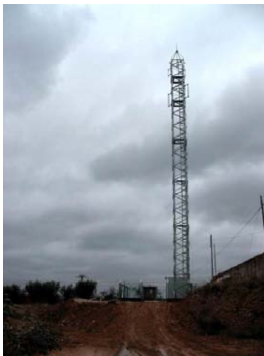
Imatge 73. Camí d'accés a una instal·lació amb impacte sobre les formes de relleu, amb potenciació del procés d'erosió. Centre de Telecomunicacions d'Esparreguera, al terme municipal d'Esparreguera (Baix Llobregat). Fotografia de Yolanda Garcia. 07/01/2002.
