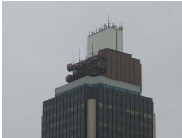
Imatge 129. Exemple de recrescut vertical. Edifici on està situada una central de telecomunicacions a la ciutat de Nantes, a la regió de País del Loira (França). Fotografia de l'autor. 24/08/2003.
