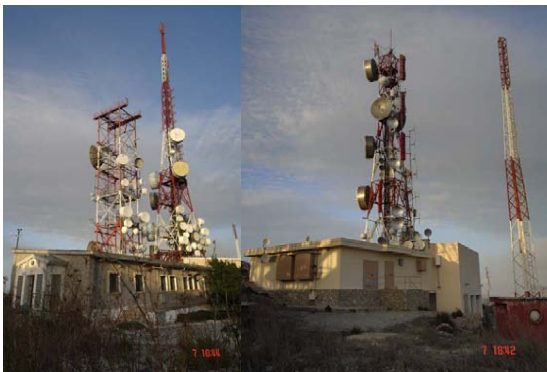
Imatge 45 i Imatge 46. Els Centres de Telecomunicacions d'Alfàbia (Mallorca). A l'esquerra el de l'empresa Retevisión, a la dreta el de Tradia. Fotografies de l'autor. 07/10/2004.
