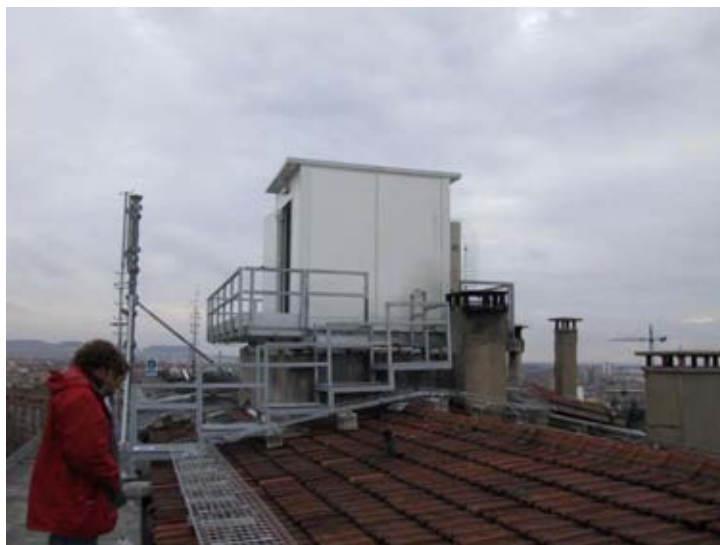
Imatge 67. Estació urbana de telefonia mòbil per l'operador Xfera. Situada al carrer García Morato, núm. 31. de Valladolid (Castella – Lleó). És un exemple de la tipologia "T-3. Caseta Urbana". Aquest emplaçament, de ben segurs s'hagués pogut resoldre a sota la coberta
