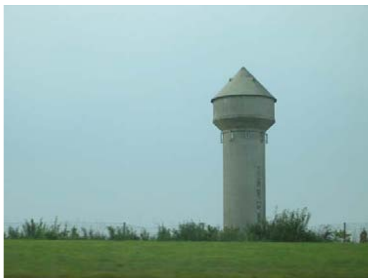
Imatge 131. Exemple de mimetització modalitat mobiliari rural. Dipòsit d'aigua, en una població situada a la carretera A-10, prop de la localitat de La Rochelle, a la regió de Poitou-
