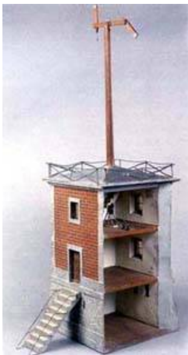
Imatge 15. Maqueta d'una torre del telègraf òptic de Chappe. Il·lustració del COIT. 26/08/2006.
