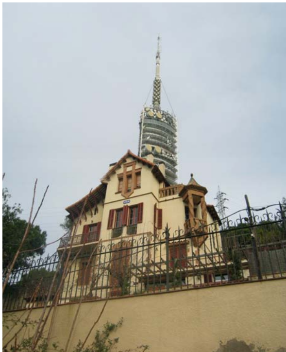
Imatge 62. La Torre de Telecomunicacions de Collserola. De 285,00 m d'altura. Situada al cim de la Serralada de Collserola a prop del Tibidabo. Fotografia de l'autor. 29/12/2002.
