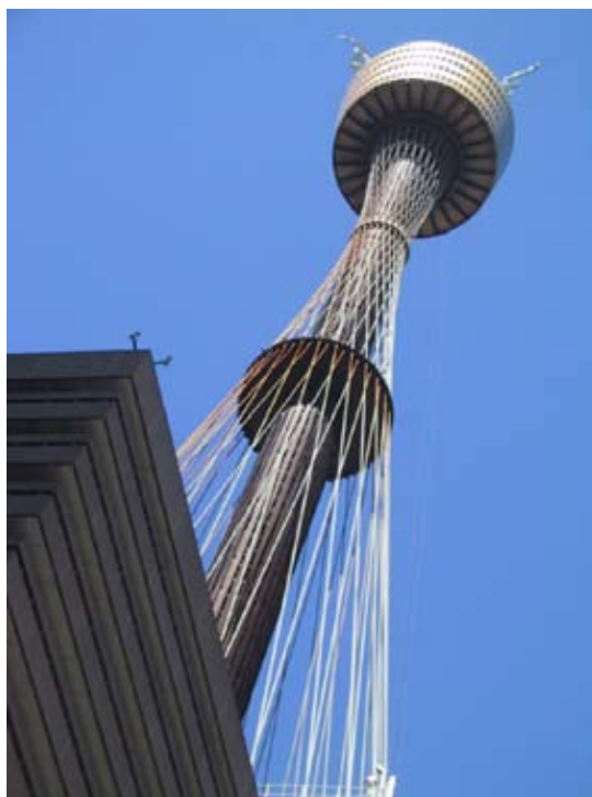
Imatge 59. La Torre de Sydney (Austràlia). Torre del tipus mixte, amb 305,00 m d'altura. Fotografia de Damien Koh. 26/12/2000.
