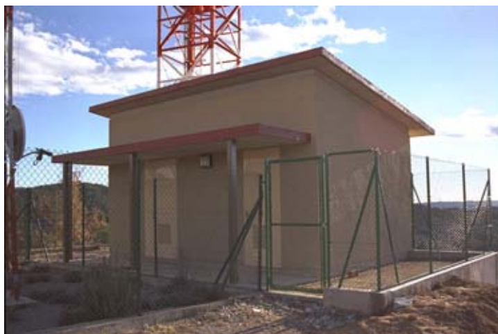
Imatge 114. Centre de Telecomunicacions d'Oliana, Oliana (Alt Urgell). Centre mitjà de dues sales amb torre de 25,00 m. Fotografia de l'autor. 18/06/1998.
