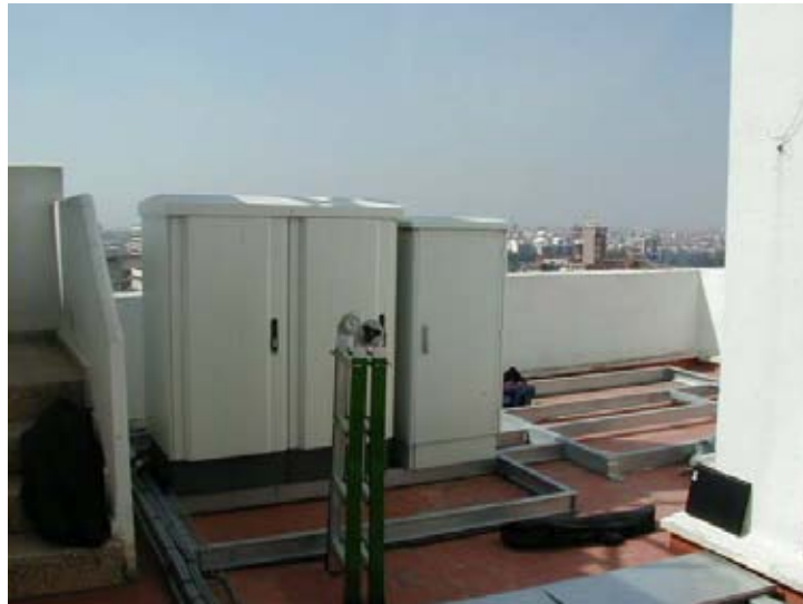
Imatge 69. Exemple de tipologia "T1. Outdoor urbana". Instal·lació efectuada al carrer Batxiller, núm. 17, a la ciutat de València (País Valencià). Fotografia de l'autor. 15/07/2000.
