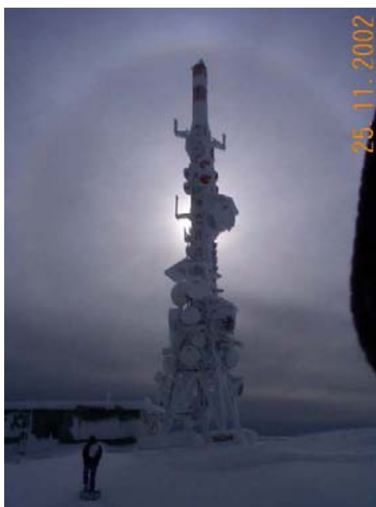
Imatge 58. La Torre de Centre de Pic de l'Orri, al terme municipal de Soriguera (Alt Urgell), coberta de gel. Torre del tipus metàl·lic, amb 72,00 m d'altura. Fotografia de Jaume Clavera. 25/11/2002.
