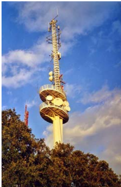
Imatge 60. La Torre de Telecomunicacions de Platja d'Aro (Baix Empordà). De 60,00 m d'altura. Fotografia de Jaume Clavera. 11/12/1999.
