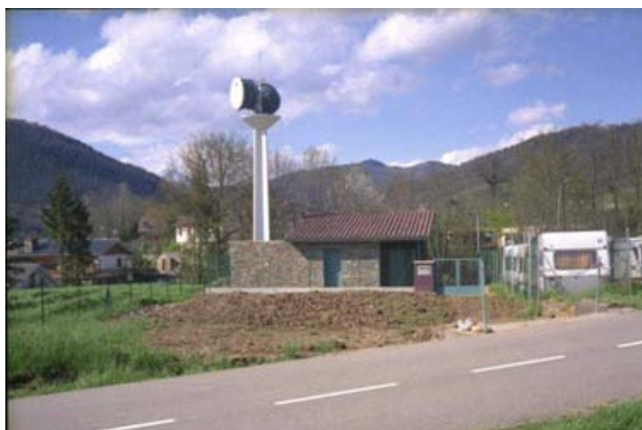
Imatge 108. Centre de Telecomunicacions de Sant Pau de Seguries. Sant Pau de Seguries (Ripollès). Centre únic amb torre de disseny de 12,50 m. Fotografia de l'autor. 16/05/1996.
