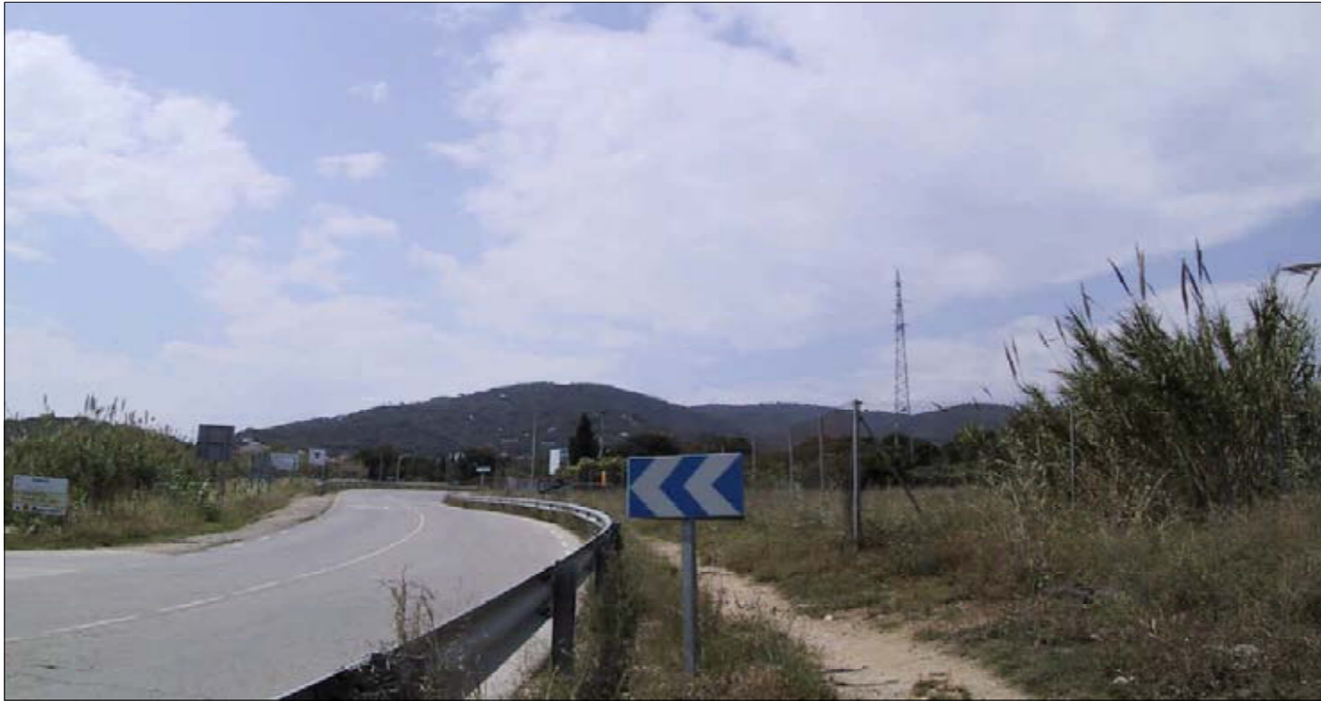
2A.- PREMIÀ DE DALT - PONT AUTOPISTA - ESTAT ACTUAL
