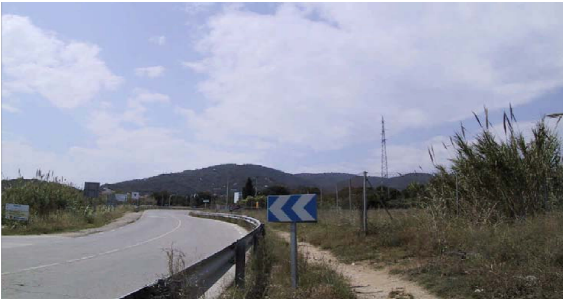
2A.- PREMIÀ DE DALT - PONT AUTOPISTA - ESTAT REFORMAT
