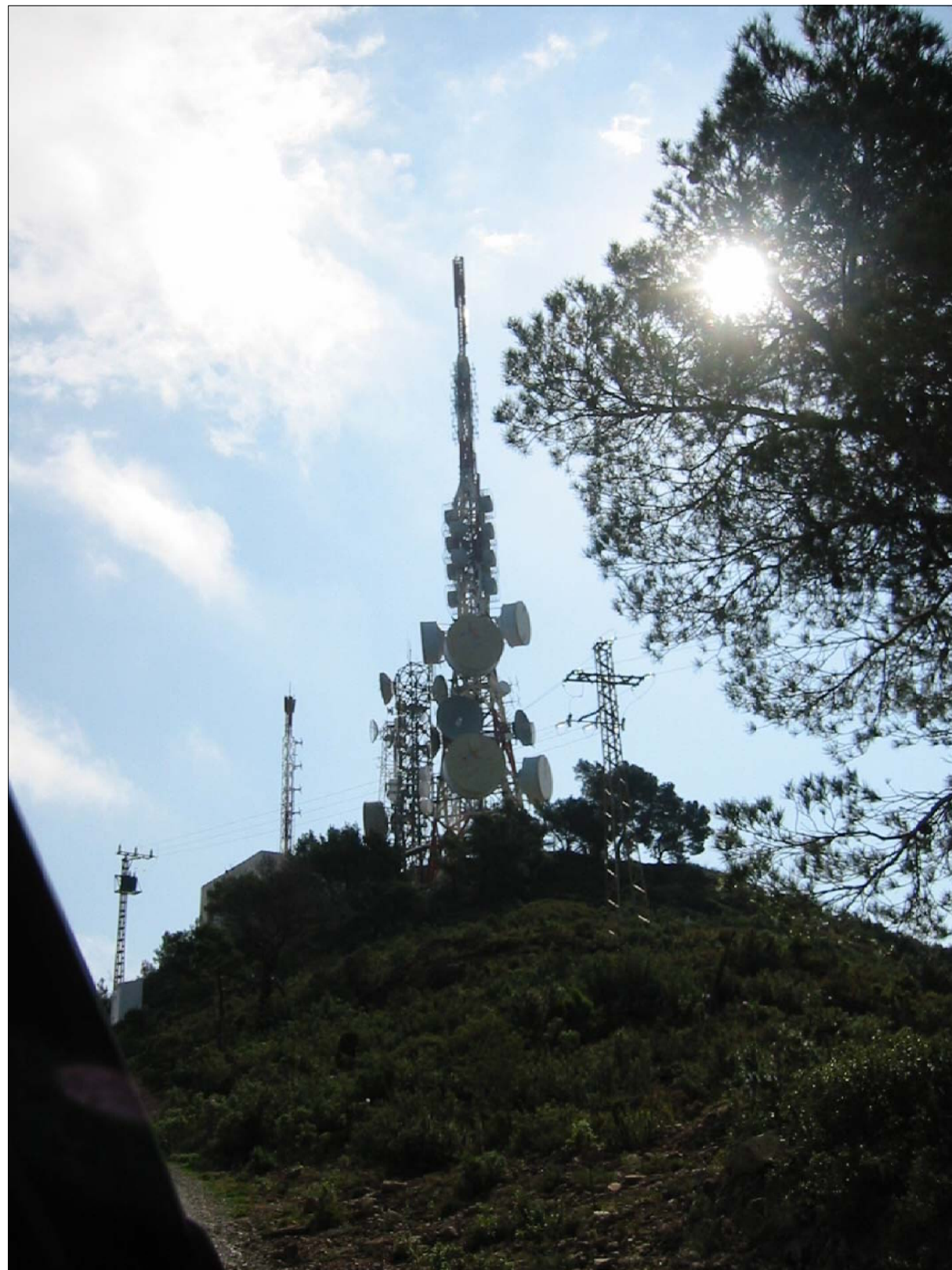
6.- CAMINO DE ACCESO - BARTOLO. (ESTADO ACTUAL).
