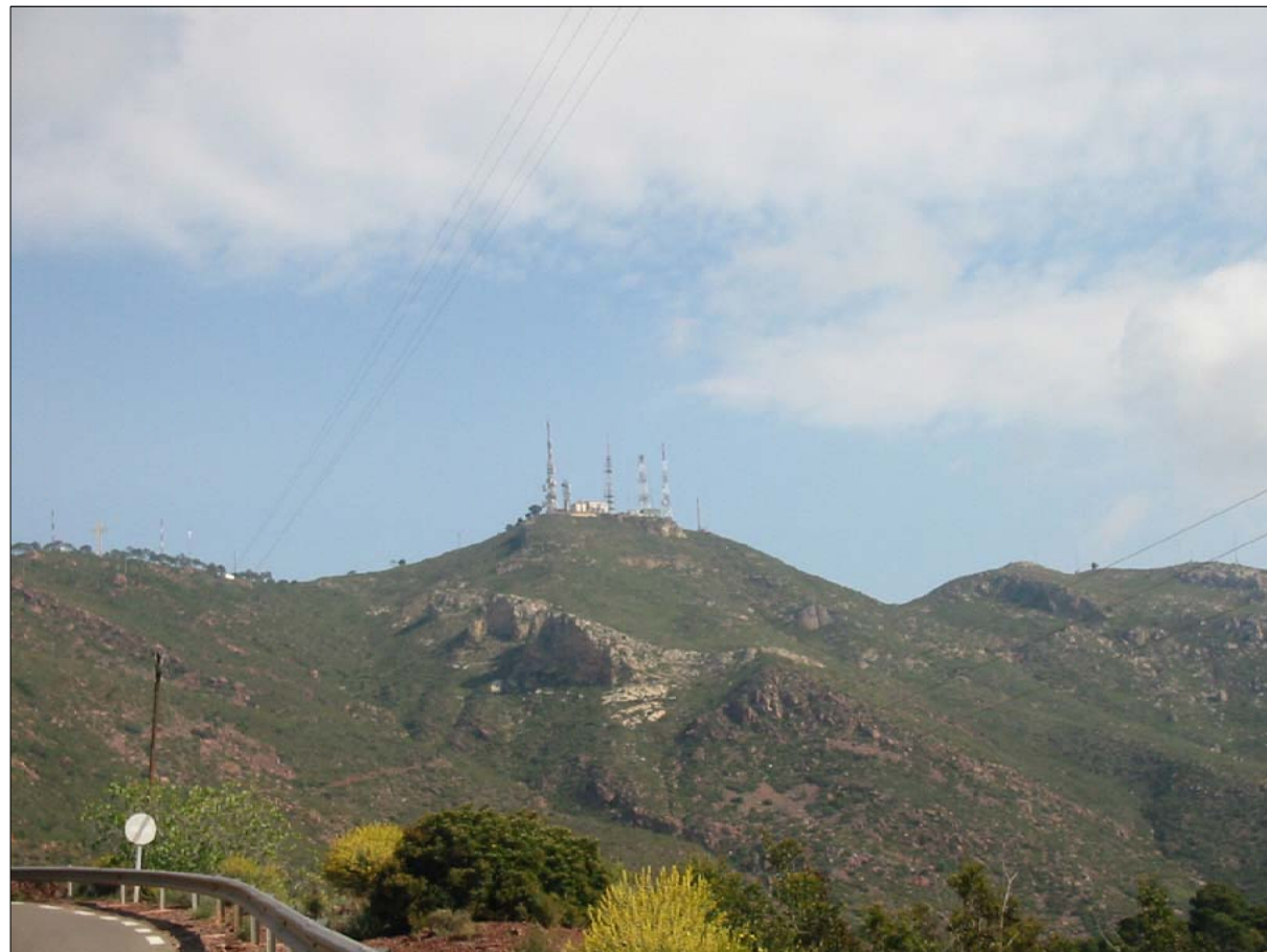
3.- CARRETERA DE ACCESO DESDE CASTELLÓN - CASTELLÓN. (ESTADO REFORMADO).
