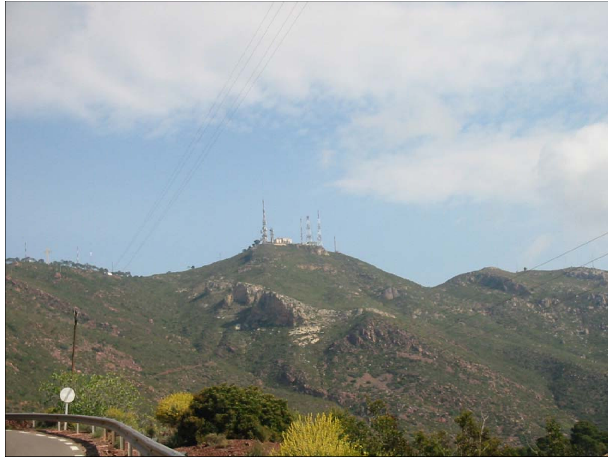
3.- CARRETERA DE ACCESO DESDE CASTELLÓN - CASTELLÓN. (ESTADO ACTUAL).
