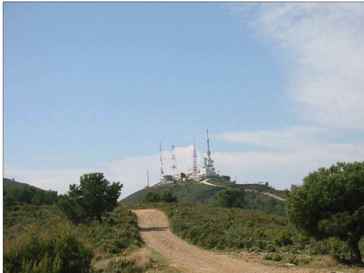
4.- CAMINO DE ACCESO LADO MONTAÑA - BARTOLO. (ESTADO REFORMADO).
