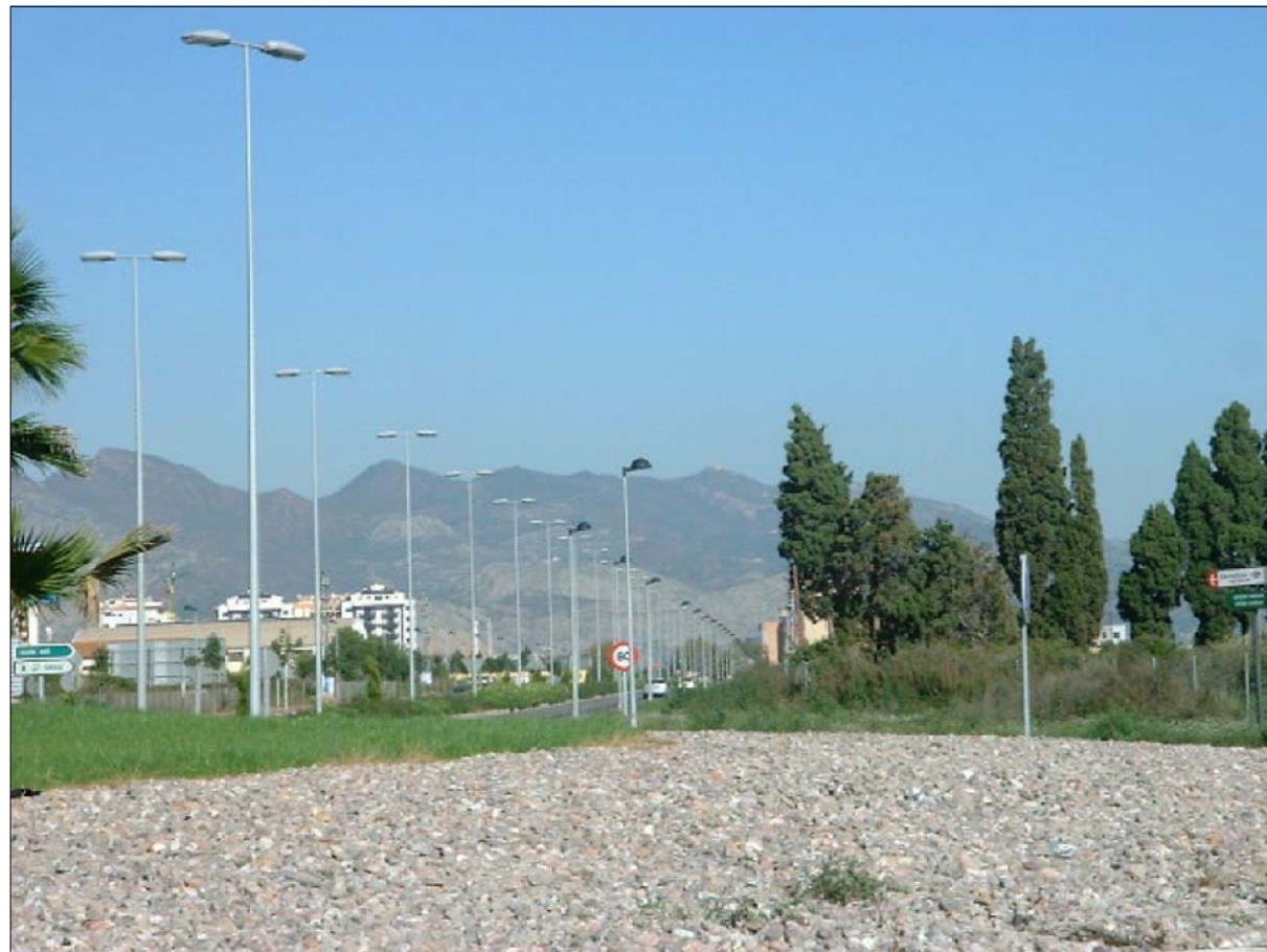
1.- CASTELLÓN CIUDAD - CASTELLÓN. (ESTADO REFORMADO).
