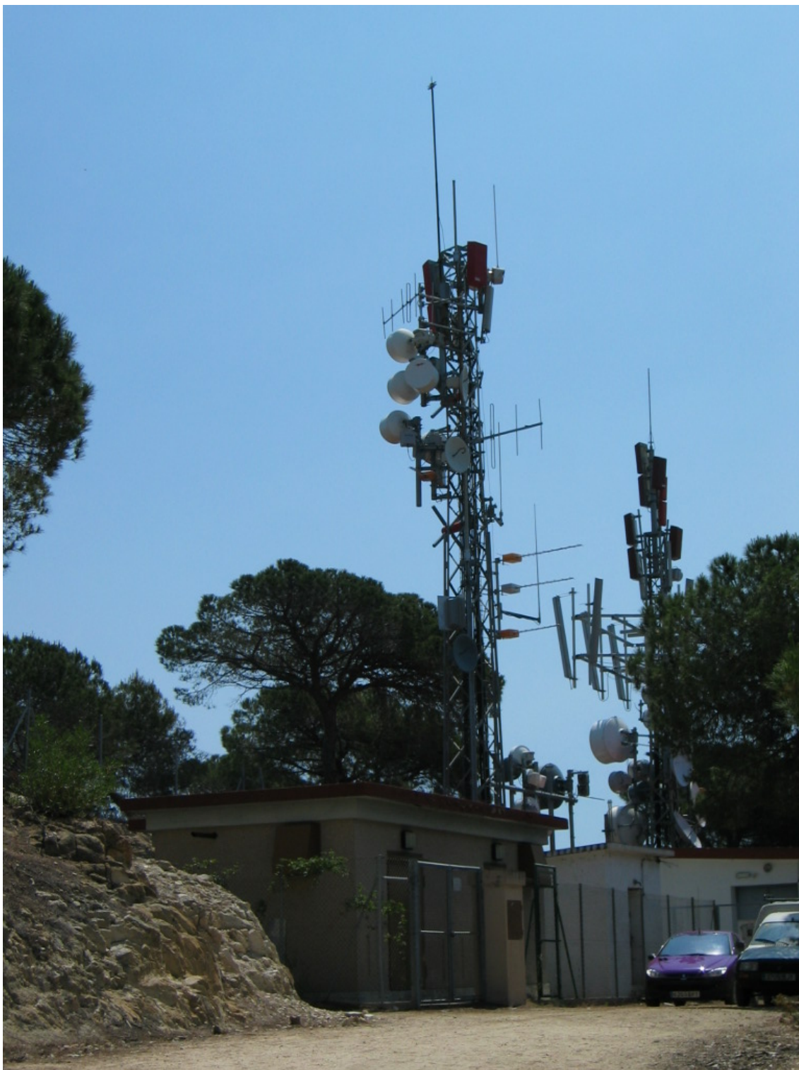
FOTO 02 – VISTA A PEU D'INSTAL·LACIÓ
