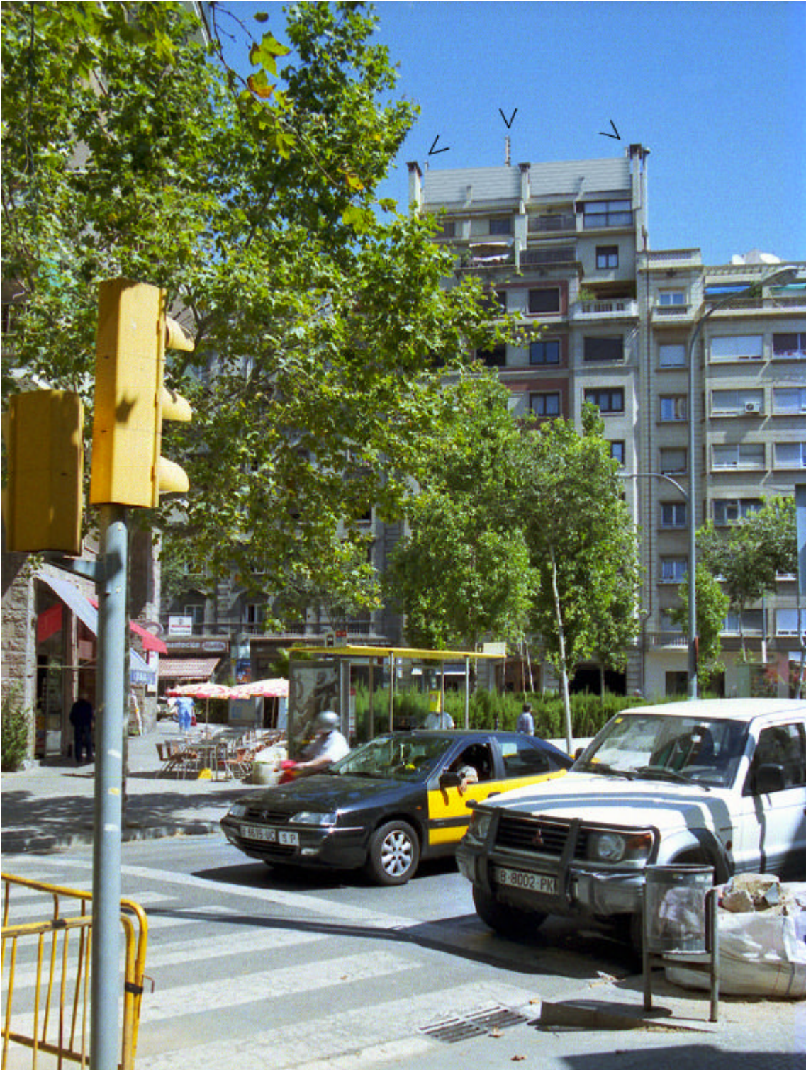
Fotografia 3. La caseta es troba dins del con de visió, està ubicada propera al pla de façana i de la volumetria existent. Els elements que impacten visualment són el lateral de la caseta i els màstils M2, M3 i M4. La caseta està totalment camuflada amb plafons.
