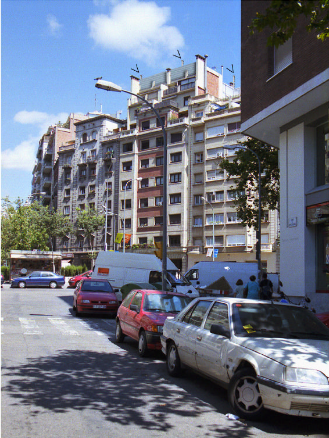
Fotografia 2. La caseta es troba dins del con de visió, està ubicada propera al pla de façana i de la volumetria existent. Els elements que impacten visualment són el lateral de la caseta i els màstils M1, M3 i M4. La caseta està totalment camuflada amb plafons.
