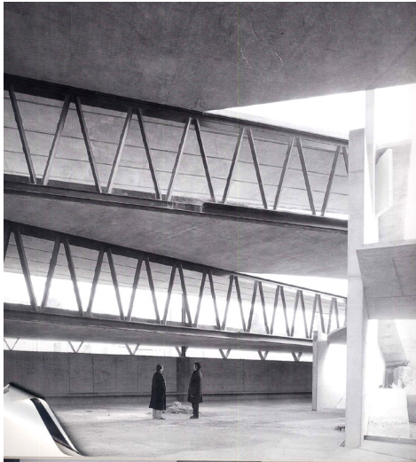
Miralles/Pinos- Centro Cultural de Hostalets en Construcción. 1990
