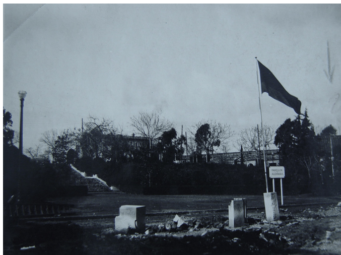
F.30 | Parcel·la inicial destinada a la construcció del Pavelló Alemany Museum of Modern Art, MoMA
