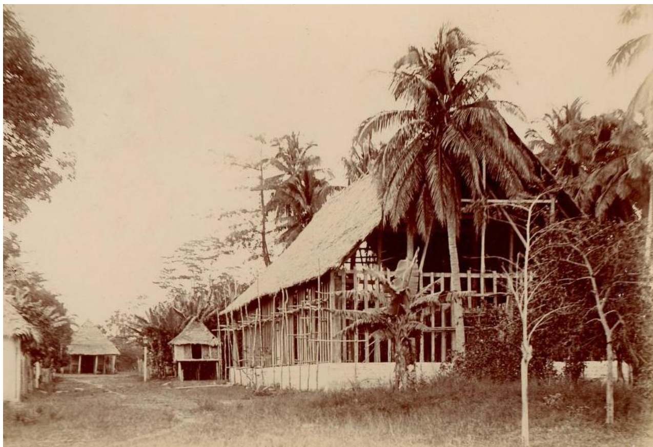
Figura 44. Iglesia de Mati en construcción (1895)
