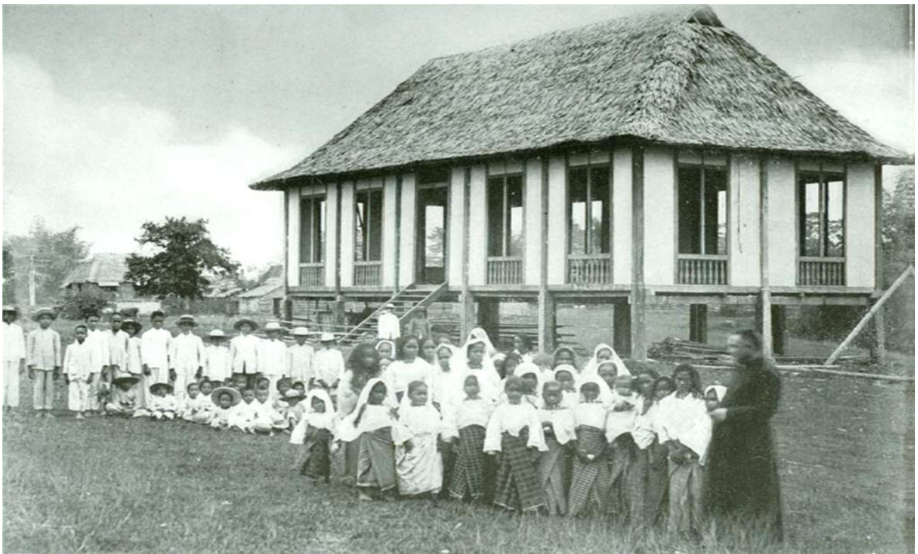
Figura 45. Escuela en construcción en Las Mercedes, provincia de Zamboanga (1895) 199
