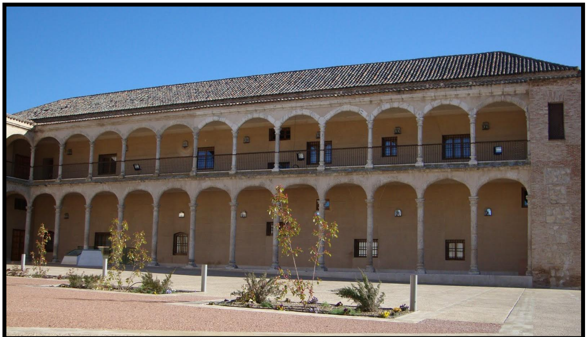
Fig. 18. Restos del patio del palacio que mandaron a construir los duques de Maqueda en Torrijos a principios del siglo XVI. Fue su residencia habitual de la familia esa centuria y la siguiente. Imagen: Autor, 2015.
