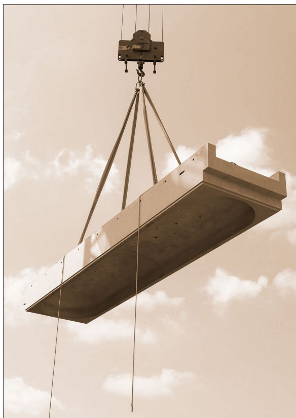
Fig. 4.1.1 Pieza estructural prefabricada de geopolímero a base de ceniza volante. Queensland's Global Change Institute (GCI) University - Australia (2013).
