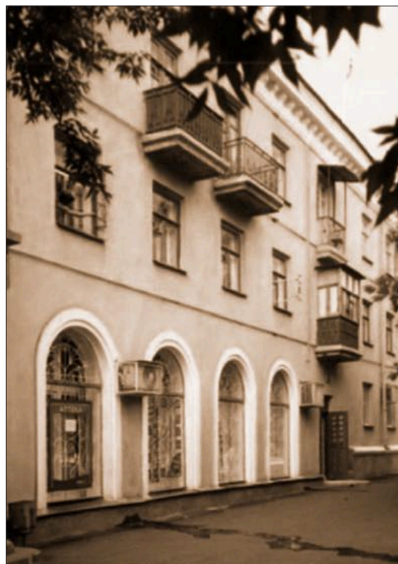
Fig. 4.11.1 Edificio residencial en Mariupol, Ucrania, construido a partir de bloques prefabricados de escoria activadas con hidróxido alcalino (exterior revestido de yeso).
