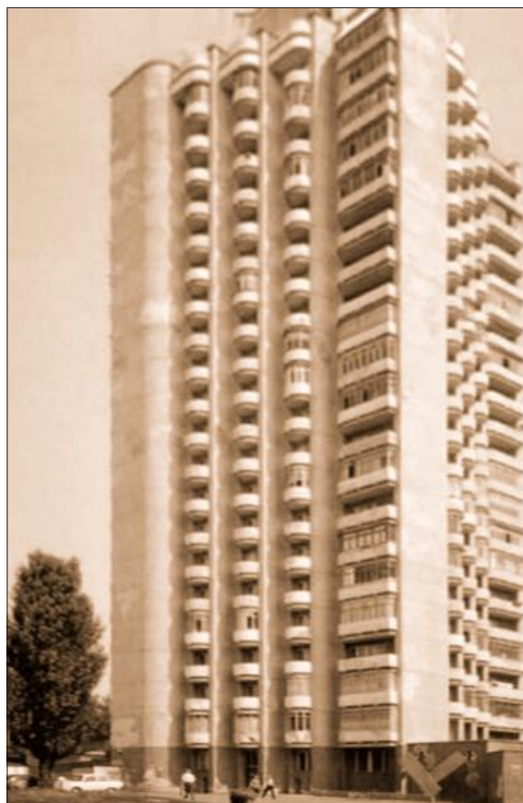
Fig. 4.11.2 Edificio de 24 pisos construido con hormigón de cemento de escoria activada por álcali, Lipetsk, Rusia, 1994.
