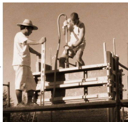
Fig. 2.3.2b La innovación de los elementos y sistemas constructivos con tierra ha sido principalmente impulsada por la implementación de tecnología, es decir, uso de herramientas y maquinaria que ha facilitado y optimizado la aplicación del material.
