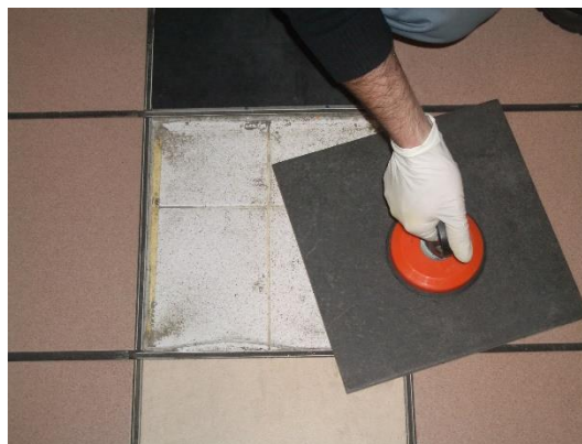
Figura 3.24 Contador óptico y sistema de instalación sin adhesivo para facilitar la retirada de piezas.
