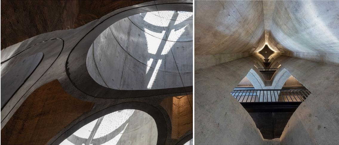
Fig. 5.68a, b. Zeitz Museum, MOCAA. Visitantes observando el Atrio central. Vista cenital de los intersticios entre silos perforados por pasarelas, vista donde se pueden apreciar los cortes en los silos originales y los refuerzos interiores. Detalle de los lucernarios superiores donde se aprecian los refuerzos interiores y los cortes en los silos. Ciudad del Cabo. Sudáfrica. Proyecto 2001-2017. Fotos; Grant Durr / Iwan Baan. Fuente; <http://www.heatherwick.com/projects/buildings/zeitz-mocaa/>
