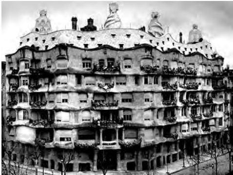
Casa Milà. Estado original
