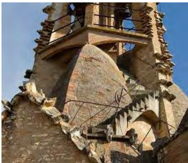
Cubierta Iglesia Vistabella.
