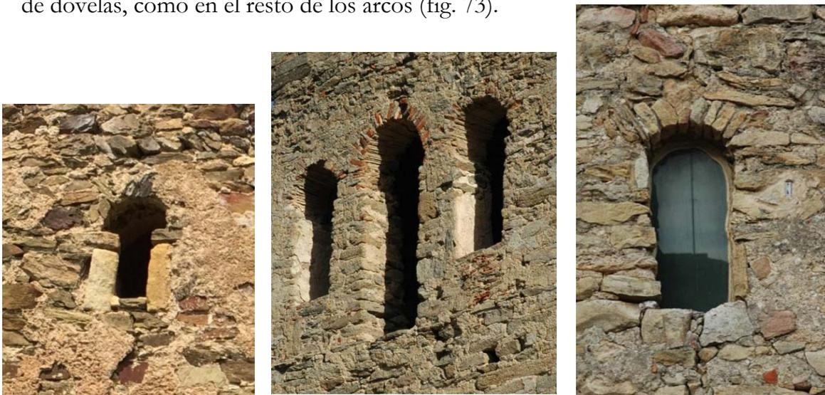
Figura 73. Arcos de ventanas formados con diferentes tipos de lajas en Sant Climent de Peralta, Santa Creu o Santa Helena de Rodes y Sant Julià de Boada. Fotos de M. Valls Mora.
