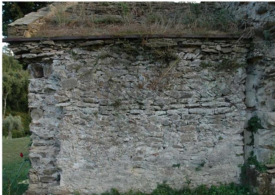
Figura 75. Lajas que restan de la cubierta original del ábside de Sant Climent de Peralta. Fotografía de M. Valls Mora.
