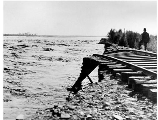
**Figura 26.** Fotografía que muestra los daños causados al ferrocarril de la Southern Pacific Railroad en 1904 por la inundación del delta del río Colorado. Fuente: A century of service imperial irrigation district.
