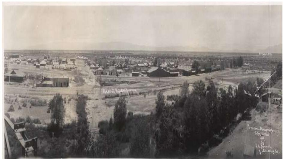
**Figura 5.** En el trazado de Calexico en el lado estadounidense se aprecia una manzana tipo de 100m x 115m aproximadamente, incluyendo su callejón en el lado más largo, unas manzanas más cuadradas que las rectangulares en el caso de Mexicali. En el lado mexicano, las manzanas eran aproximadamente de 180m x 130m, también con su callejón en su lado más largo. Cabe mencionar que algunas de las calles coinciden a pesar de la frontera entre los dos países.
