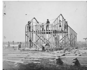
**Figura 83.** Se denomina Balloon frame (cuya traducción desde el inglés podría ser armazón de globo) a un tipo de construcción de madera característico de Estados Unidos, consistente en la sustitución de las tradicionales vigas y pilares de madera por una estructura de listones más finos y numerosos, que son más manejables y pueden clavarse entre sí. Fuente: <http://www.arqhys.com/>
