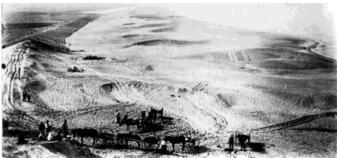
Figura 85. Treballs de fixació dunar a Empúries, l'Escala, al voltant del 1896. De fons s'observen les morfologies barkhanoides perpendiculars a la costa originades per la tramuntana
