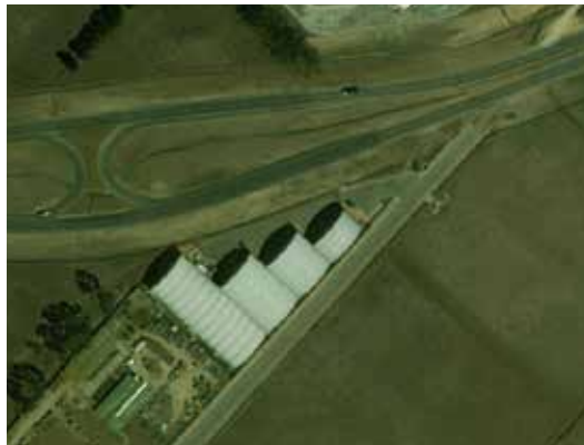
Imagen 70. Naves adosadas, (2018). Fuente: Bing Maps
