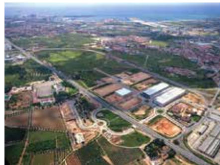
Figura 175. Centro logístico el Camp, Reus-Tarragona. Fuente: Centros logísticos: planificación promoción y gestión, 2012.
