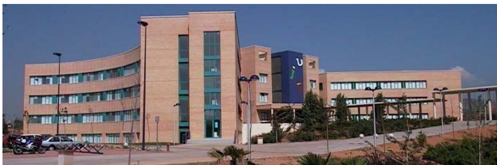
Figura 31. Fotografía del exterior del edificio TI en el Campus Riu Sec de la Universidad Jaume I de Castellón
