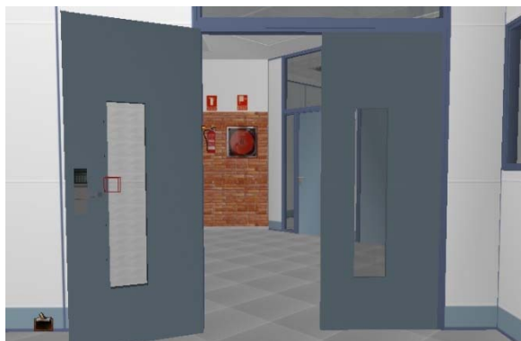
Figura 59. Puerta de laboratorio con apertura mediante pulsador situado en la esquina inferior izquierda de la imagen
