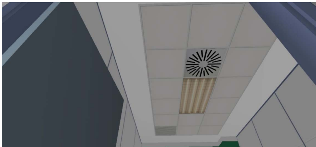
Figura 49. Techo suspendido registrable de un despacho del edificio TI con rejillas y fluorescentes
