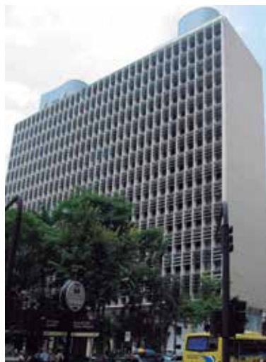
162 Edificio Gustavo Capanema. Wikimedia Commons contributors. Wikimedia Commons, the free media repository. 2014. File: MESP4.jpg
