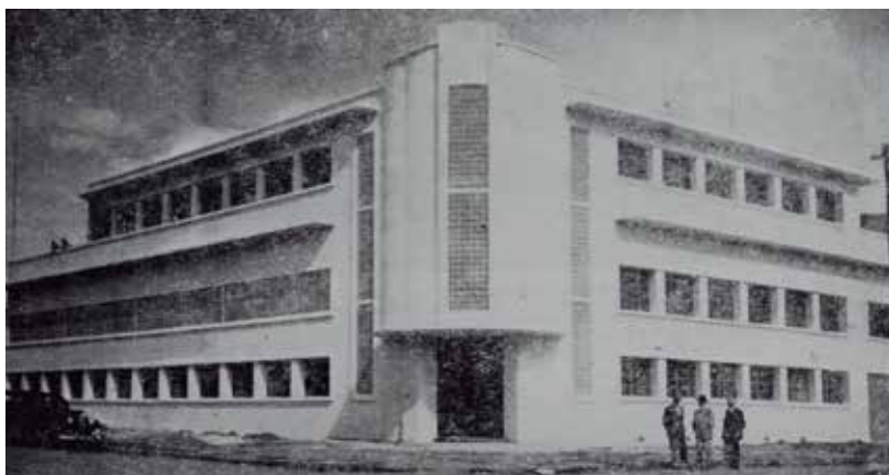
54 Central de teléfonos automáticos de la zona norte, barrio La Mariscal. Revista Andes , N° 13, Junio-Julio de 1956. p. 16
