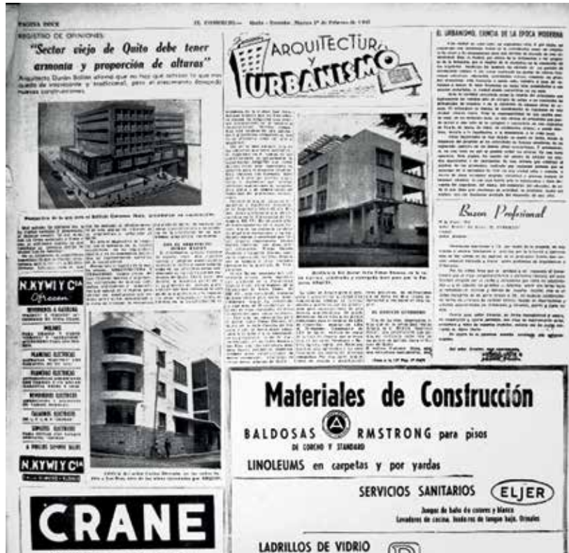
252 Portada de la primera publicación de la sección Arquitectura y Urbanismo. De izquierda a derecha: edificio Guerrero Mora, Casa Tobar Donoso and edificio Carlos Mercado. Constructor: ARQUIN. El Comercio , Martes 1 de febrero de 1955, p. 18.
