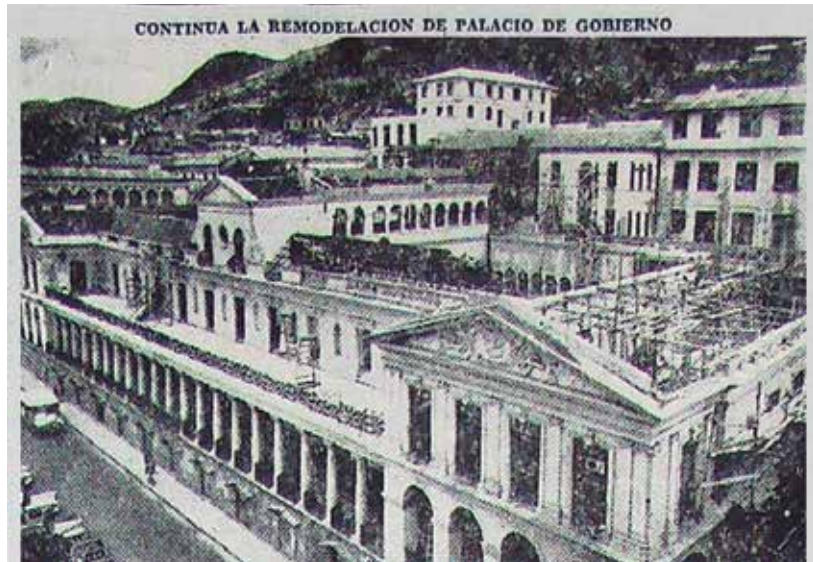
153 En la imagen se distinguen las estructuras en hierro que se colocaron al interior del bloque norte del Palacio Presidencial. El texto insiste en que "se han hecho notables cambios, pero sin afectar a su estilo [...] profusión de arcos y columnas que hablan de una ciudad de imponente arquitectura". El Comercio , Martes 30 de junio de 1959, p. 18.
