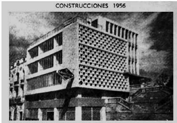
319 Edificio Arteta. Construcción de uso mixto entre almacenes y oficinas. Construido por Edificaciones Ecuatorianas. Llamó la atención por su acople a la escalinata en el lado sur. El Comercio , Martes 6 de noviembre de 1956, p. 13.
