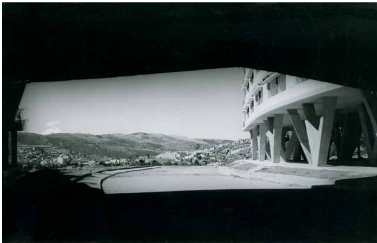
188 Vista de la planta libre de la Residencia de la Universidad Central del Ecuador. Aproximadamente 1965. En Fondo Quito, ID: 3599. Cortesía de la Biblioteca Ecuatoriana Aurelio Espinoza Pólit.
