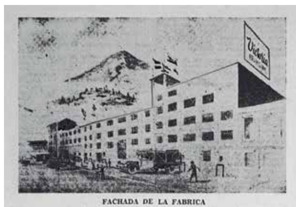
17 Edificio Cervecería y maltería La Victoria S.A., El Comercio , Sábado 28 de mayo de 1958, p. 12
