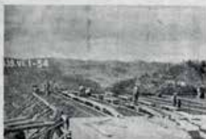
436.V.4-54 Vista de los terminados de reformas de la losa del techo del compartimiento este.
