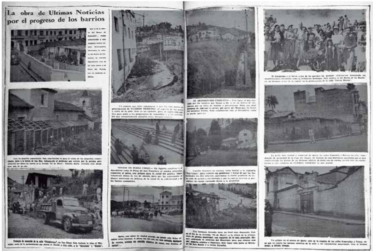
51 La imagen ilustra los cambios que se dieron en 1953 en algunos sectores de la ciudad como resultado de las denuncias hechas por el rotativo en relación con solares sin uso, falta de puestos de comercio y pavimentación, semovientes en zona urbana, vivienda autoconstruida en solares vacíos en la zona centro; también resalta la colaboración vecinal en forma de mingas para arreglos urbanos. Últimas Noticias , sf. enero de 1954, sp.
