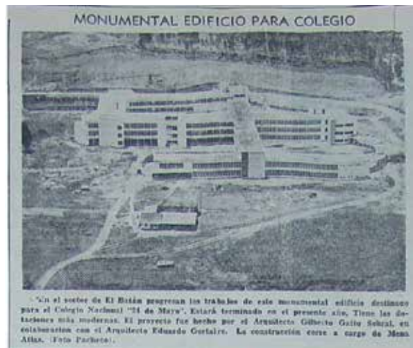
24 Colegio 24 de Mayo, en construcción. El Comercio , Martes 15 de abril de 1958, p. 14
