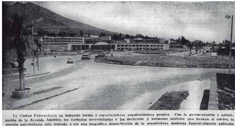
247 Vista hacia el norte de la Av. América. Al costado izquierdo se observa el edificio administrativo de la Universidad Central del Ecuador. El Comercio , Martes 21 de julio de 1959, p. 18.
