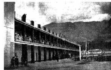
Edificio del Colegio Municipal Benalcázar - Pintado con WESCO
