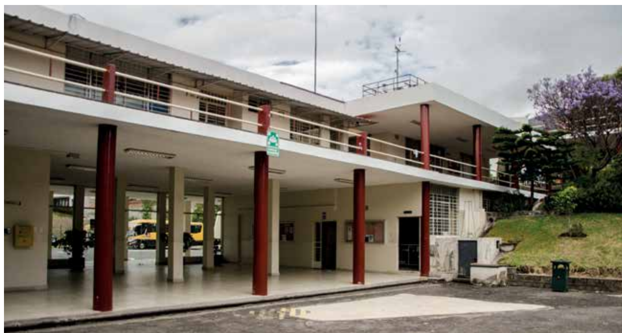
296 Edificio Colegio San Gabriel. Fotografía: Belén Velasteguí, 2017
