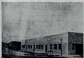
Filtros Rápidos. Vista exterior de la Sala de Operaciones terminada.
