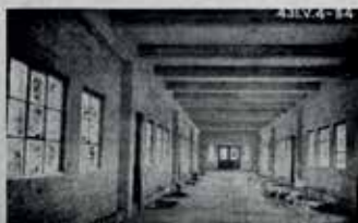
Filtros Rápidos. Vista interna de la Sala de Operaciones.
