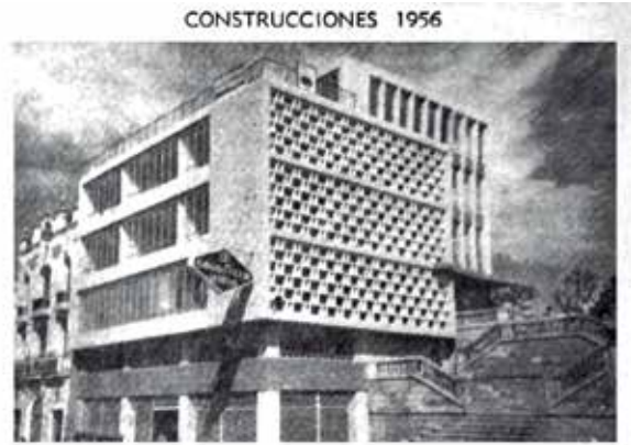
13 Edificio Arteta Alameda. La prensa resaltó los tres frentes y la articulación con la escalinata. El Comercio , Martes 6 de noviembre de 1956, p. 13
