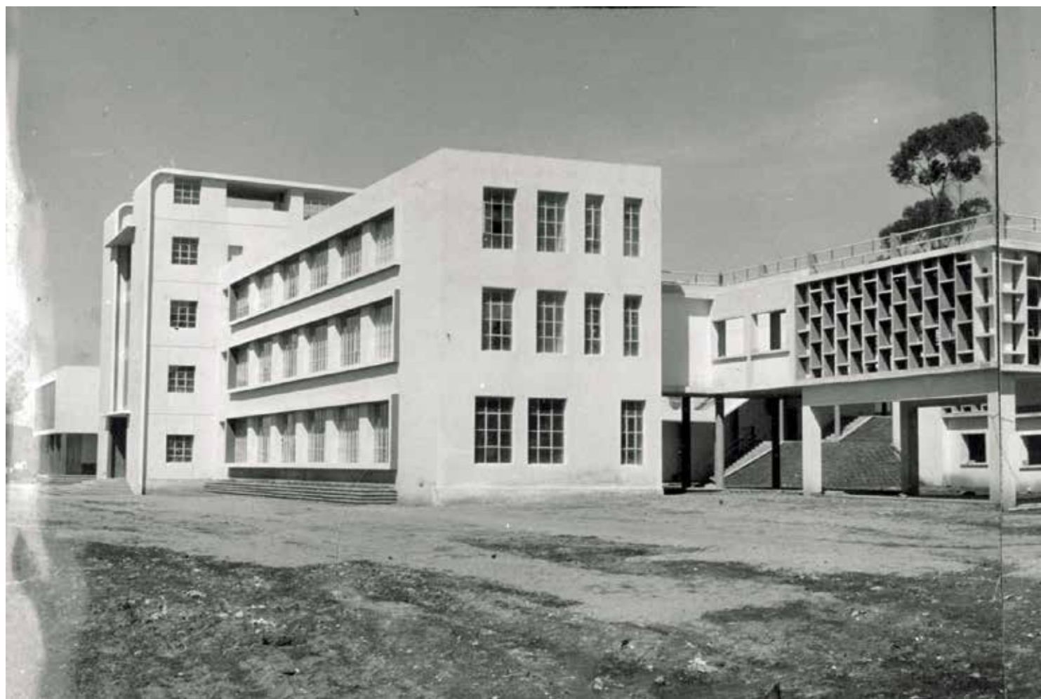
293 Colegio San Gabriel, Quito. Aprox. 1960. Vista hacia el sur-occidente. En Fondo Quito, ID: 11069. Cortesía de la Biblioteca Ecuatoriana Aurelio Espinoza Pólit.
