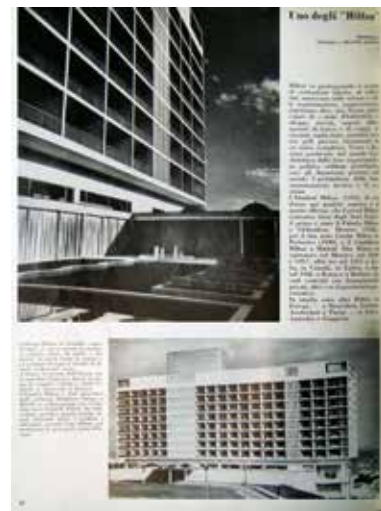
163 Hotel Hilton de Estambul de Skidmore, Owins & Meril, arch. El texto resalta "Hilton va punteggiando il mondo di costruzioni tipiche, di edifici che, americani nelle misure en el la organizzazione, rapresentano, protemmo dire, una forma particolare di "unité d'habitation". Domus. Maggio. 318. 1956, p. 12
