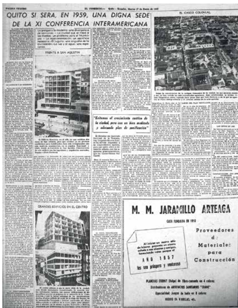
65 El 1 de enero de 1957, las imágenes que alimentaban la proyección estética de Quito para la Conferencia, resaltaban por su composición de placa y torre. Los edificios Guerrero Mora, Bolívar y Casa López se ubican en el centro, a pocas cuadras de la Plaza Mayor llamada de La Independencia, que se observa en el lado superior izquierdo. El Comercio , Martes 1 de enero de 1957, p. 4
