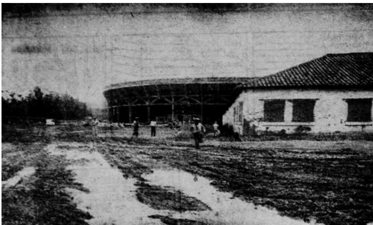
347 Ante el mal estado de los alrededores de la plaza en la época invernal se solicita al Municipio que urbanizara la zona de modo que fuera funcional en el momento de la inauguración en marzo de ese año. El Comercio , Viernes 4 de marzo de 1960, p. 19.
