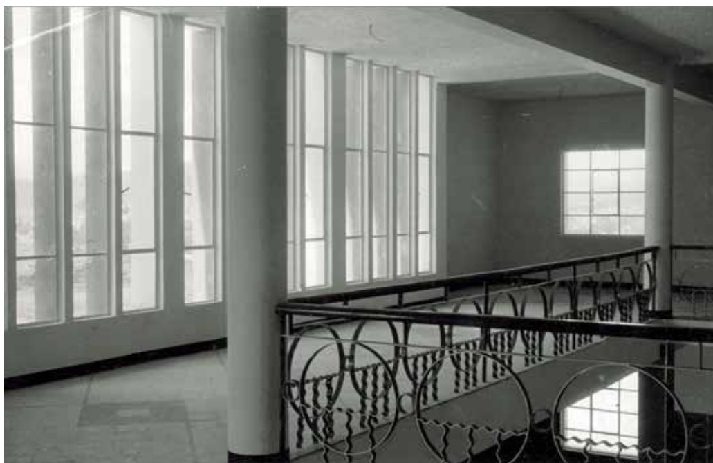
292 Colegio San Gabriel, Quito. Aprox. 1960. Vista corredor interior. En Fondo Quito, ID: 11086. Cortesía de la Biblioteca Ecuatoriana Aurelio Espinoza Pólit.
