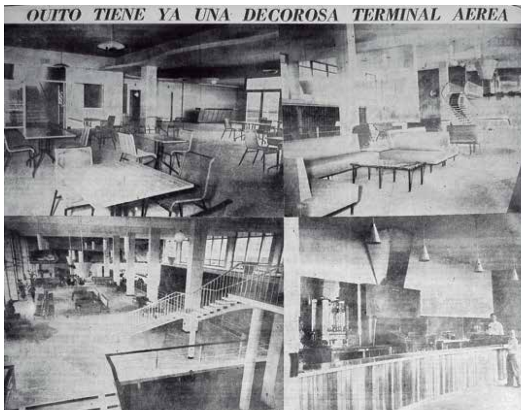
178 Composición que muestra los interiores del edificio terminal del aeropuerto en Quito, a pocos días de la inauguración. El Comercio , Jueves 25 de agosto de 1960, p. 11.
