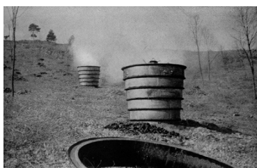
[110] Hornos metálicos carbonizadores. Imagen del artículo sobre la explotación de Valsain por Regiones Devastadas.
