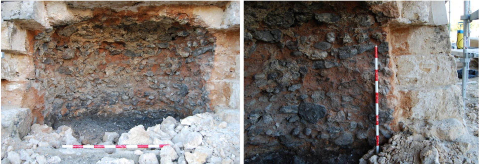
Figuras 1-2. FOTOGRAFÍAS BASE MURALLA, RELLENO ENTRE CONTRAFUERTES O ESTRIBOS, RECUBIERTOS POR CAMISAS DE PIEDRA. Del artículo *Resultados del Control Arqueológico en El Baluarte Del Príncipe de La muralla Renacentista de Palma de Mallorca*, de las *IV Jornades d'Arqueologia de les Illes Balears (Eivissa, 1 2 d'octubre, 2010)*. *Cueva pequeña y detalle del relleno de la muralla*, Antonia Martínez.
