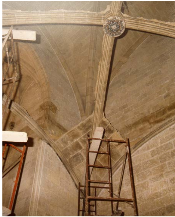
Desmontaje de la bóveda de la Sala dels Vermells de la Catedral de Mallorca.
