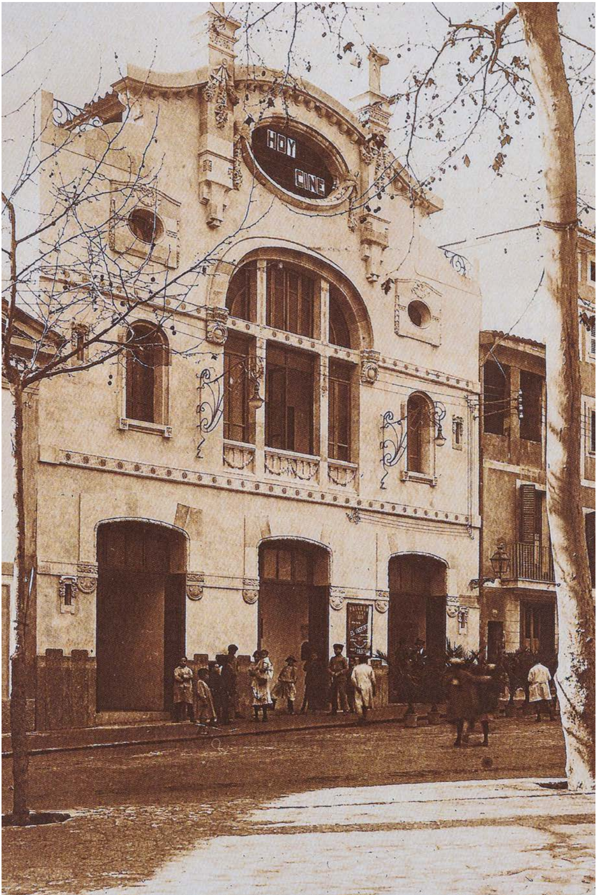
Cine Moderno de Palma (demolido).
