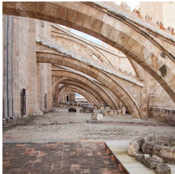
Bóveda intermedia y tejadillos eliminados.
