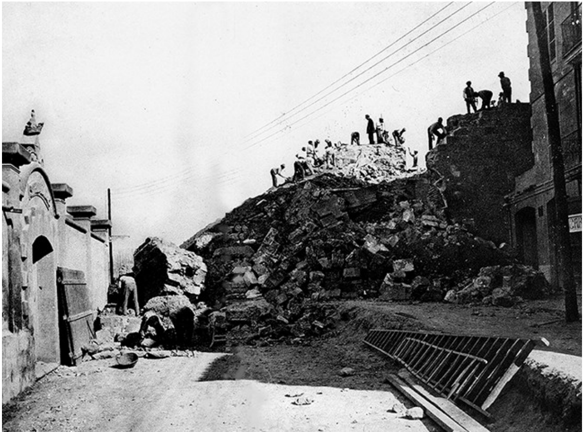
Demolición de la Puerta de Santa Margarita.
