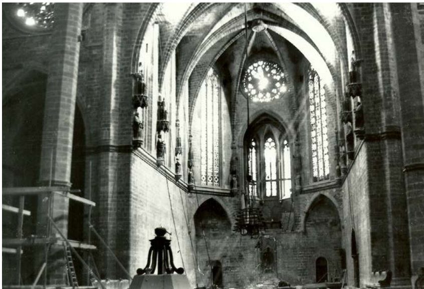
Desmontaje del retablo original gótico.
