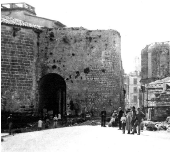
Instantáneas previas a la demolición.
