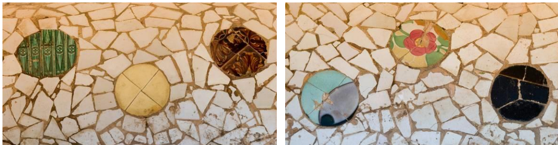
Fig. 233, 234: Detalls del trencadís de la Plaça dels bancs. Fotografia d’Holguer Strauss
