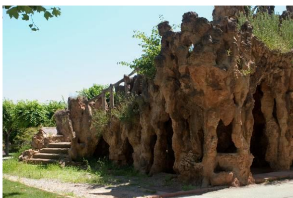
Fig. 135: Viaducte de la Cova-cascada.
