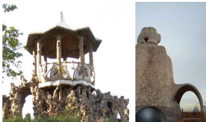
Fig. 180: Façana de la Casa Milà. Fig. 181: Façana de les fonts de la Cova-cascada del Parc Sanitari de Sant Joan de Déu. Fig. 182: Arcs parabòlics de la Cova-cascada. Fig. 183: Arc parabòlic i xemeneia del terrat de la Casa Milà.
