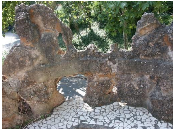
Fig.145: Respatller del Pont intermig del Park Güell.
