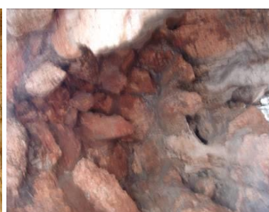
Fig.148: Voltes apuntades al Pont intermig del Park Güell.
