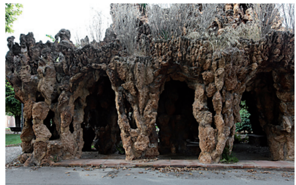
Figura 7. Pilars perimetrals de la «Cova cascada» del conjunt modernista del Parc Sanitari Sant Joan de Déu. | Pilares perimetrales de la «Cueva cascada» del conjunto modernista del Parque Sanitario San Juan de Dios.
