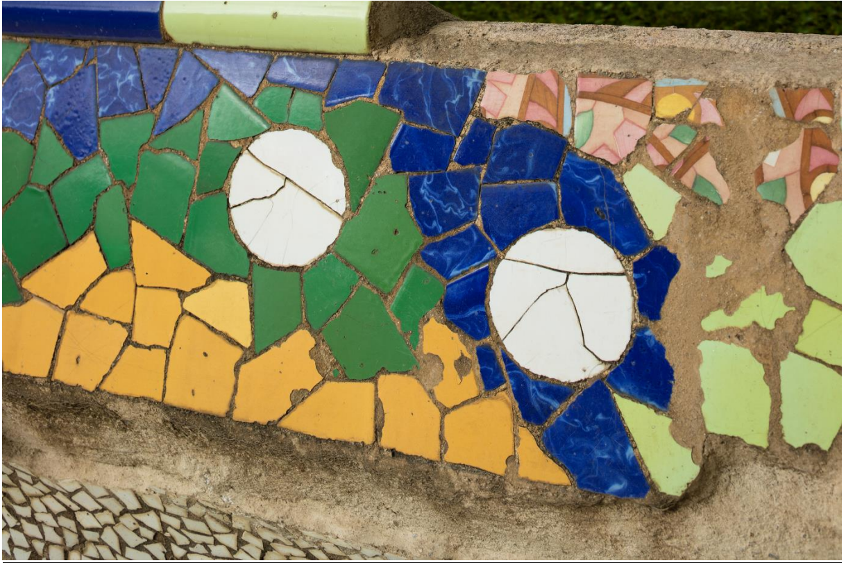
Fig. 330: Trencadís de banc del conjunt modernista del Parc Sanitari Sant Joan de Déu. Fotografia: Aleix Bagué.
