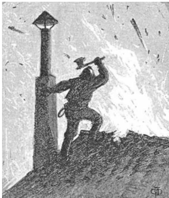
Fig. 10. Bomber destraller intentant realitzar un exutori en el sostre d'un edifici. Gravats de mitjans del segle XIX. Autor desconegut. Font: Jesús Mestre Campí, Bombers de Barcelona... , p. 8
