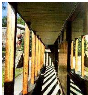
Figura 92. Exterior Genel House. Ordenamiento modular de la estructura.
