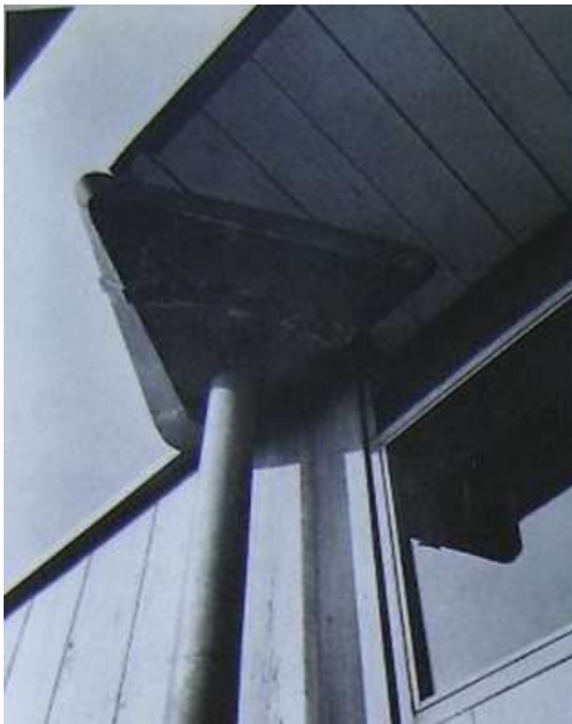
Figura 99. Weiss House, bajante de aguas triangular, Kahn.
