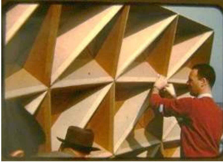
Figura 210. Un slide de Kahn, de varios, sobre un domo de cartón construidos por estudiantes de Fuller en Yale University a finales 1952.
