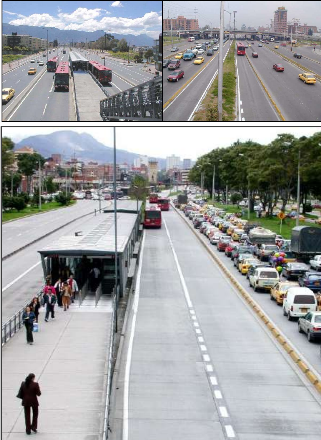
Figura 17. Sistema BRT (Transmilenio): Carriles dobles y sencillos
