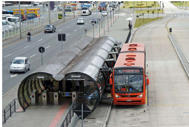
Figura 15. Carril exclusivo, bus articulado y parada “tubo” del sistema BRT de Curitiba, Brasil.
