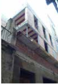
6. Nueva construcción en la calle Carabassa.
