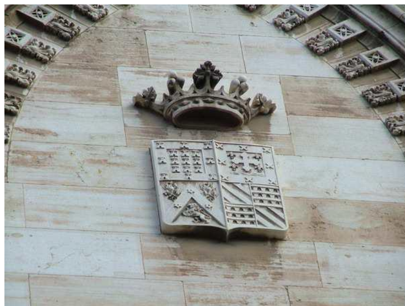
Fig.8.10 Escudo de armas del marqués de Campo. Fachada del asilo. Valencia
