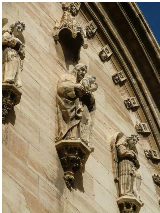
Fig. 2.6 Asilo Campo. Detalle de la fachada. San Vicente de Paul.
