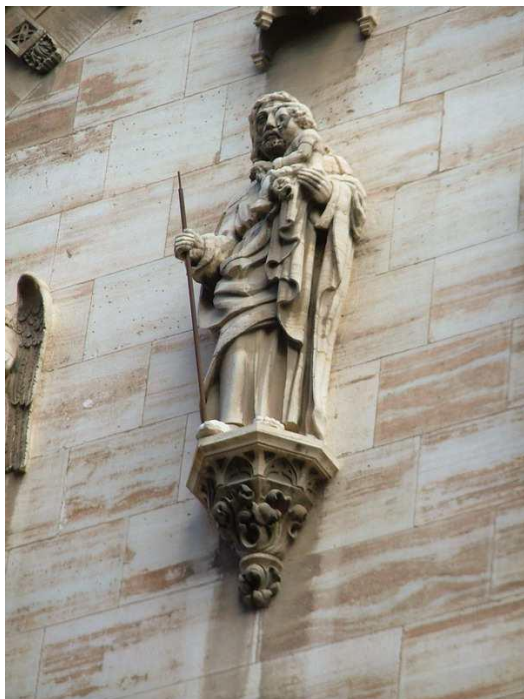
Fig. 2.5 Asilo Campo. Detalle de la fachada. San José
