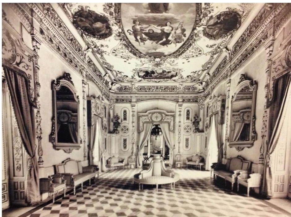
Fig.3.16 Palacio del marqués de Campo. El gran salón de baile. Época de los condes de Berbedel.
