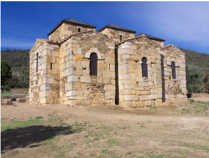
Fig. 97. Santa Lucía del Trampal, exterior
