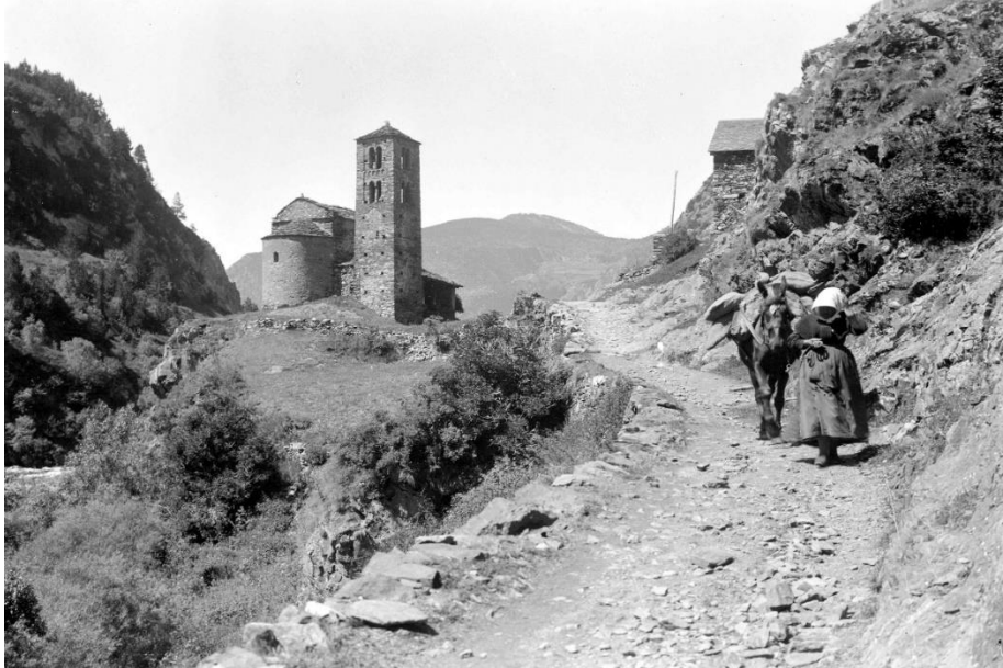
Fig. 4.7 Església de Sant Joan de Caselles des de la cara est i camí de Canillo. Possible camí de Ral. Font: ABI-DPCA.
