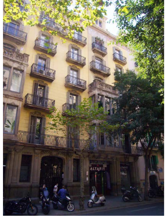
Fig. 6.1.2 Vista de l'edifici al c. Mallorca, n. 318.
