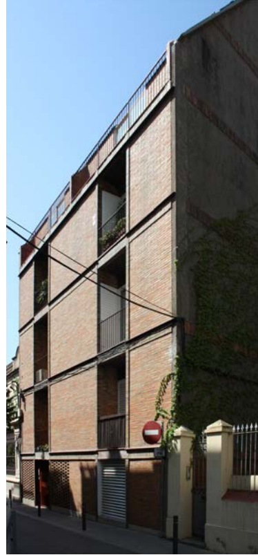
Fig. 2.3.16 i 2.3.17 Fa anes principal i posterior a l'edifici d'habitatges (ca. 1970) al c. Duquessa d'Orleans, el 2021.
