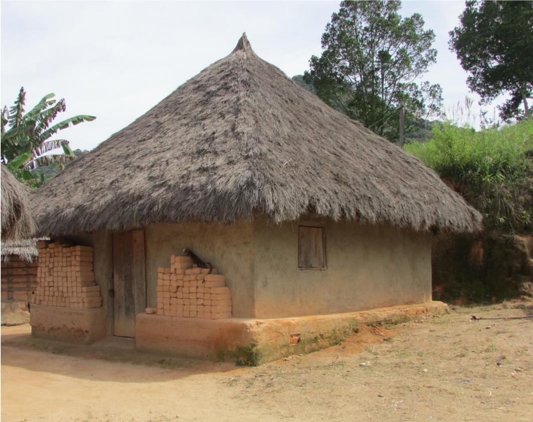
*Nota:* Vivienda tradicional en región de Dunawa construida con techo de paja y tapia pisada. La Tapia Pisada es un procedimiento por medio del cual se construyen edificaciones en tierra, sin sostenerlas con piezas de madera u otros materiales. El método consiste en apisonar tierra preparada capa por capa, en medio de dos tablonas con el espesor normal de los muros de piedra. Fotografía tomada en trabajo de campo el 7 de julio de 2021.
