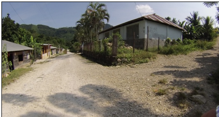
Figura 38. Detalle de infraestructuras urbanas de la localidad de El Naranjo. Foto: Amilcar Vargas.
