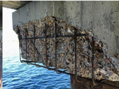
Figura 3-14 Demolición de dintel con lanza manual.
