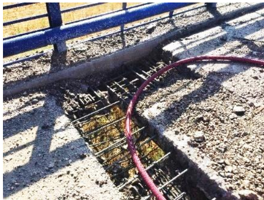
Figura 3-22-Apertura de junta de tablero en puente de vigas pretensadas con robot, sin afectación del armado.
