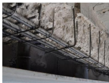
Figura 2-8 Rearmado de viga, encofrado e inyección de mortero.
