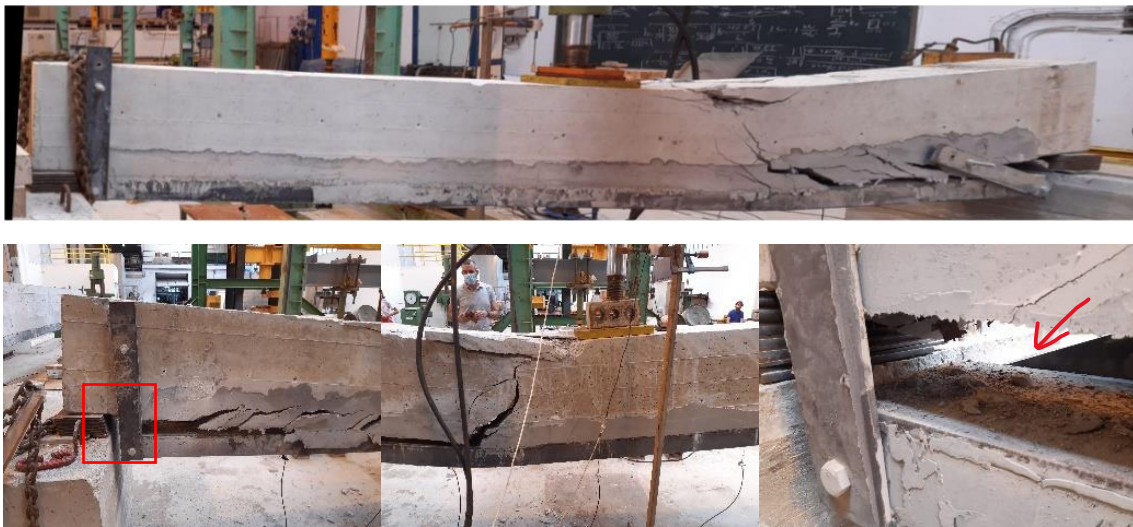
Figura 5-58 Viga 2. Vista general del fallo CDC (a) fallo por arrancamiento de conectores a cortante y tracción (b) agotamiento en cabeza comprimida y plastificación perfil (c) y ausencia de conectores en extremos por fallo constructivo (d)
