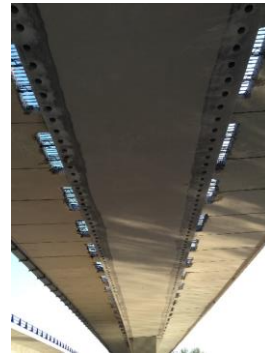
Figura A-12 Vista general de las ventanas realizadas en losa superior, y taladros pasantes realizados en base de viga con corona de diamante.
