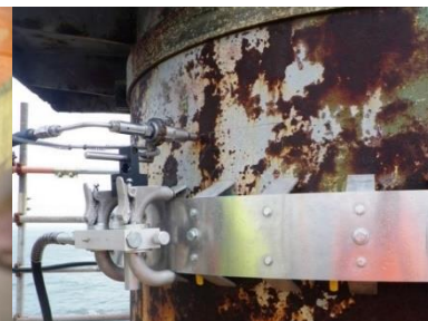
Figura 3-7 Ejemplo de útil de corte para espesor 70mm de chapa ( JetEdge Waterjets).
