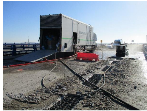
Figura A-8 Vista del robot y del grupo de presión.
