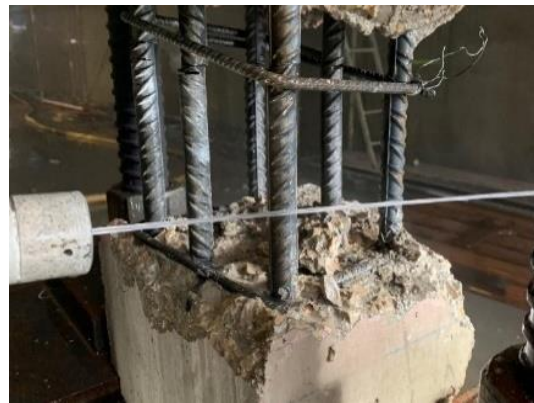
Figura 3-23 Demolición controlada de pilar para descenso de forjado posterior.
