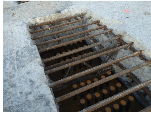
Figura 4-14 Detalle de los conectores ya en su posición definitiva.
