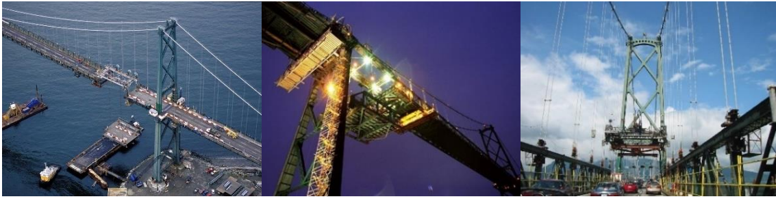
Figura 1-22 Sustitución funcional tablero mediante pontona y marco de izado: Ramsay Group en la obra Lions' Gate Bridge Project.
