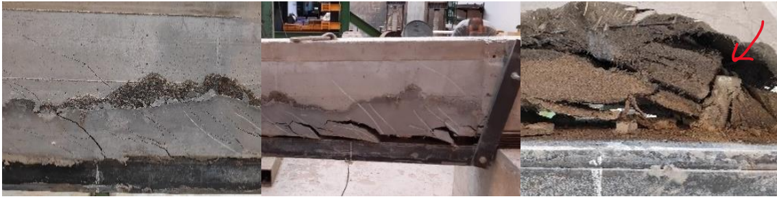
Figura 5-57 Viga 1. Vista general del fallo (a), perfecta adherencia en servicio entre mortero y hormigón (b), fallo por arrancamiento de conectores a tracción (c) y detalle del conector y la matriz de mortero con fibras (d)
