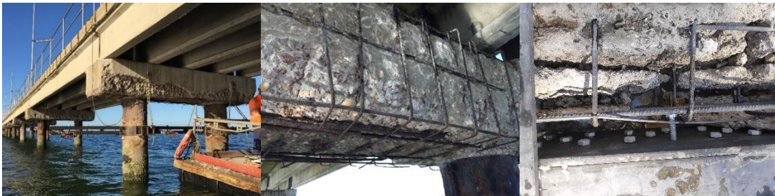
Figura 3-25 Detalle del dintel tras la demolición, con armadura desvinculada del elemento.
