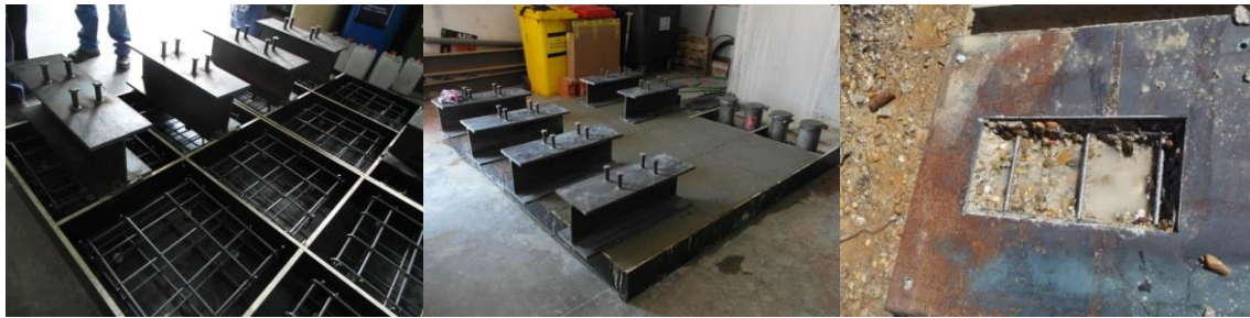
Figura 5-23 Vista de la fabricación incluyendo el ferrallado (a), el hormigonado (b) y la demolición con plantilla metálica (c).
