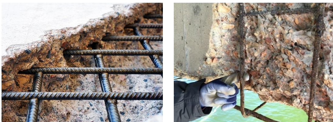
Figura 3-40. Detalle del paramento obtenido con agua a presión y elevado caudal.
