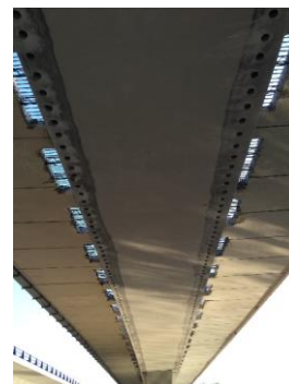
Figura 4-12 Vista de las aberturas para inserción de los conectores en la losa del tablero.
