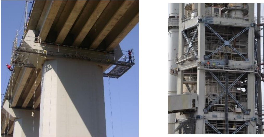
Figura 2-1 Escenarios particulares de rehabilitación: (a) Trabajos en altura (b) Cruces de arriostramiento y tirantes en torre.
