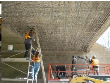
Figura 3-16 Retirada de recubrimiento de hormigón mediante repicado con brazo hidráulico, con moderada fisuración del soporte. (Diamantex).
