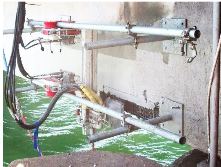
Figura 2-2 Vista conceptual de sección anexar. Figura 2-3 Robot específico trabajando en posición óptima para RCSM.
