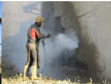
Figura 5-4 Vista de los trabajos con lanza manual sujeta por un operario especialista.
