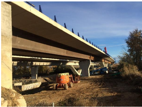
Figura A-19 Vista general de la viga pretensada reforzada en la zona de paso de pila vertical.
