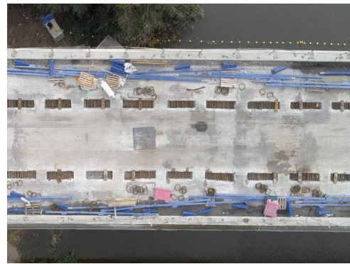
Figura A-14 Vista aérea de las ventanas de conexión con elementos de cuelgue para encofrado.
