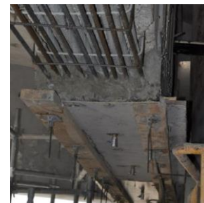
Figura 2-8 Rearmado de viga, encofrado e inyección de mortero.
