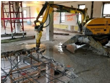
Figura 3-15 Repicado de forjado manteniendo un armado base (Mayo)
