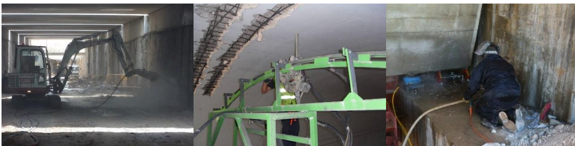
Figura 3-31 Equipos artesanales para uso en muro pantalla (a), clave de túnel (b) y zona de apoyo de viga artesa (c).
