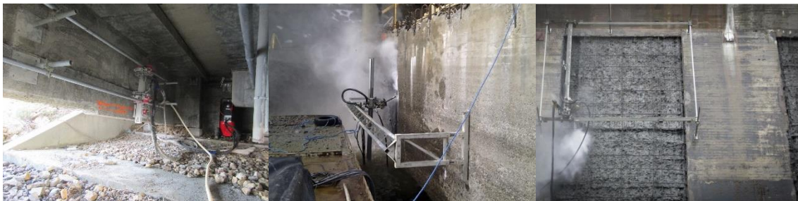
Figura 3-36 Equipo de UHP automatizado sobre tubo de andamio.
