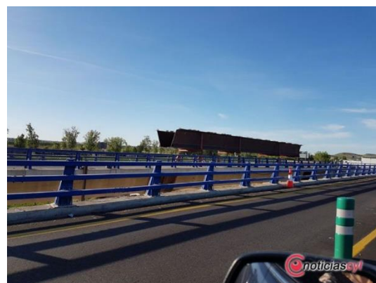
Figura 1-32 Dovela a punto de ser izada mediante grúa para su posicionamiento.
