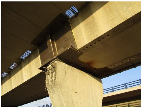
Figura A-15 Sección completa en paso de pila, con tirantes de refuerzo de la cabeza de la pila con barra de alta resistencia.
