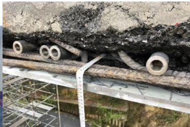
Figura 5-10 Detalle de apertura lateral mediante lanza manual, en zona densamente armada.
