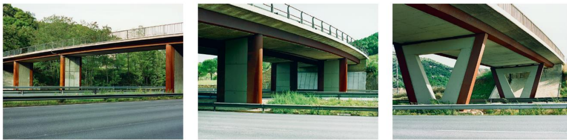
Figura 1-23 Solución combinada-mixta de “parihuelas” para ampliación de carriles AP7. (Serrano Corral & Martínez Calzón, 2021).
