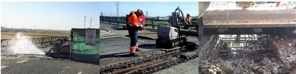
Figura 5-15 Apertura y rearmado de junta de dilatación puente de vigas
