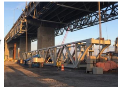
Figura 4-6 Celosía metálica para refuerzo Champlain Bridge (Vancouver). (CBC, 2017).
