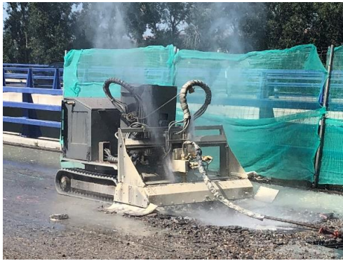
Figura A-7 Vista del robot de hidrodemolición realizando las aperturas en losa (para futura conexión de las vigas)
