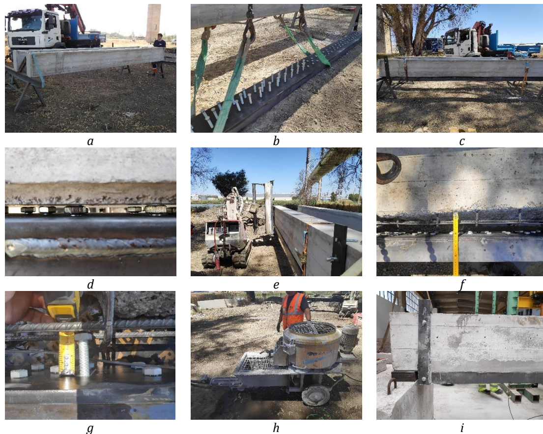
Figura 5-51 Secuencia de fabricación de las vigas.
