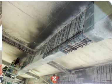
Figura 3-16 Retirada de recubrimiento de hormigón mediante repicado con brazo hidráulico, con moderada fisuración del soporte. (Diamantex).
