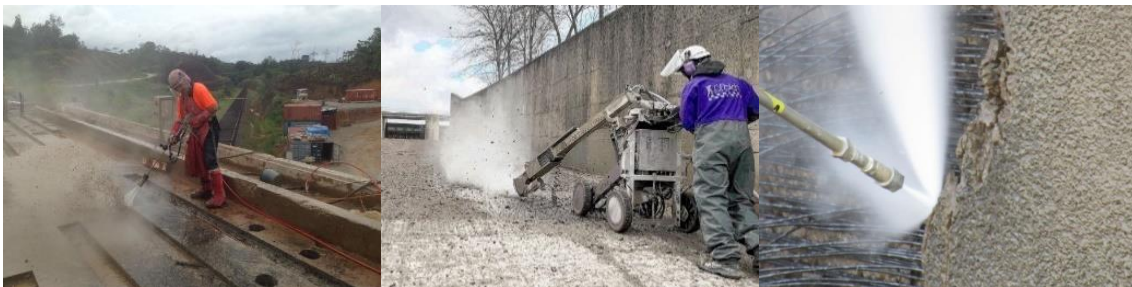
Figura 3-30 Equipos de UHP con lanza manual: sin soporte (a) y con equipo de apoyo (b) (Falch, s.f.)
