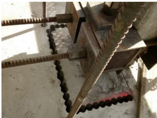
Figura 3-11 Ejemplo de corte de forjado mediante consecución de taladros pasantes (diamante). (INGETURARTE).
