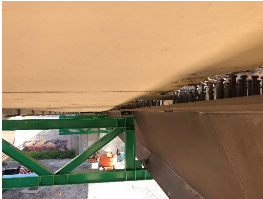
Figura 1-33 Vista de detalle de paramento superior de la viga con los conectores a punto de ser insertados en la losa de hormigón, izando la viga.
