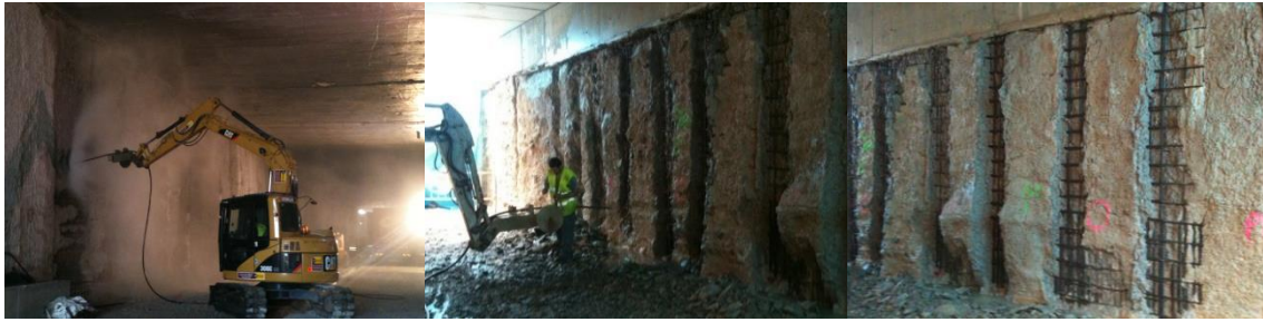
Figura 5-12 Adaptación de lanza a equipo neumático
