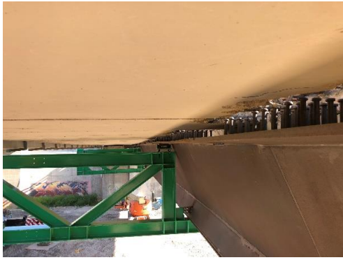
Figura A-17 Vista de detalle de paramento superior de la viga con los conectadores a punto de ser insertados en la losa de hormigón, izando la viga.
