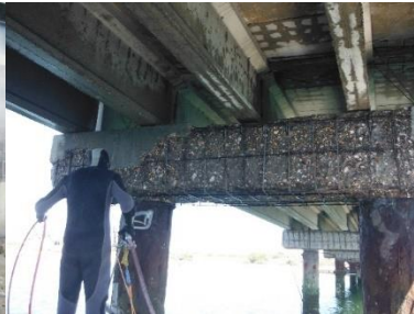
Figura 3-14 Demolición de dintel con lanza manual.
