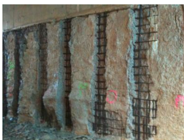
Figura 2-7 Apertura y rearmado en pantallas (por bataches).
