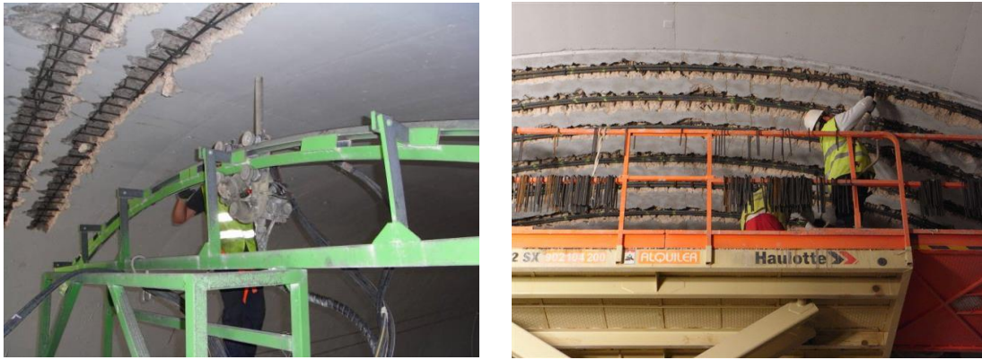
Figura 5-13 Equipo fabricado específicamente para este uso. Cabezal rígido sin movimiento.
