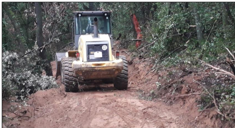
Il·lustració 58. Maquinària pesada obrint pista de desembosc
