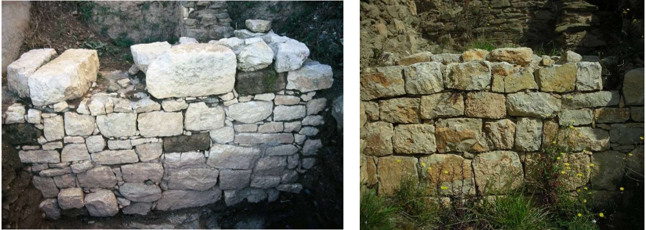
Figura. 6. Detall del parament en aparell poligonal dels murs de contenció. Es pot observar com el material general és calcari però també s'inclou algun bloc de gres amb el que es va obrar l' aedes (Foto LAP-UdG).
