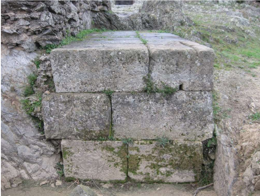
Figura. 39. Detall dels blocs de gresos Fm. Folgueroles que formaven part de la plataforma de fonamentació del Trofeu (Foto A. Guevara).
