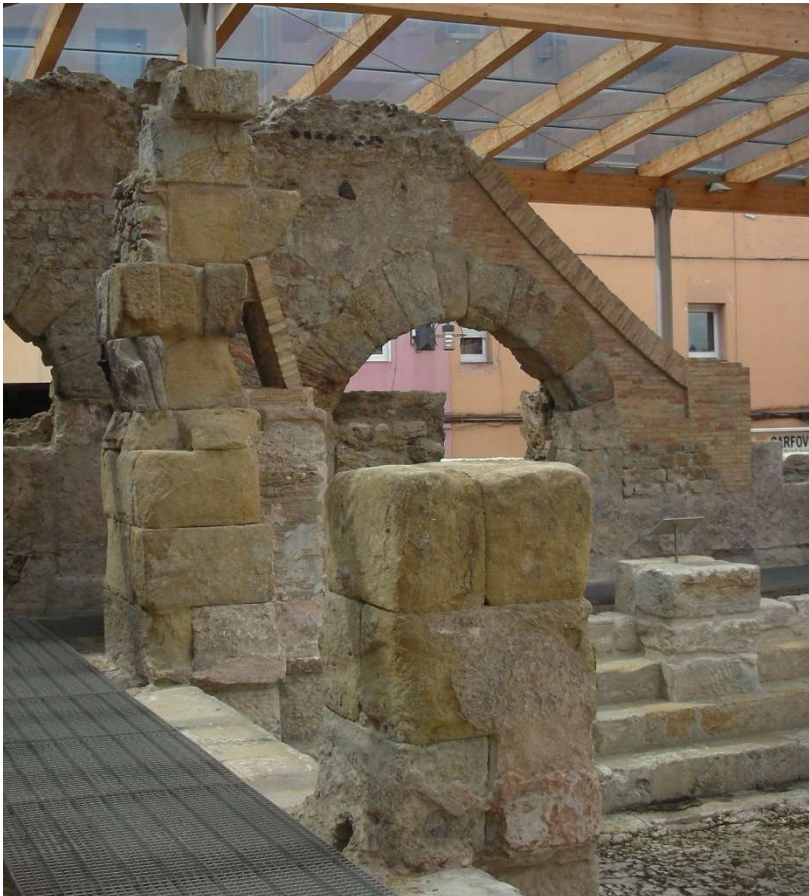
Figura. 40. Termes romanes de Caldes de Malavella. Detall dels pilars que suportaven el porticat de la natatio .
