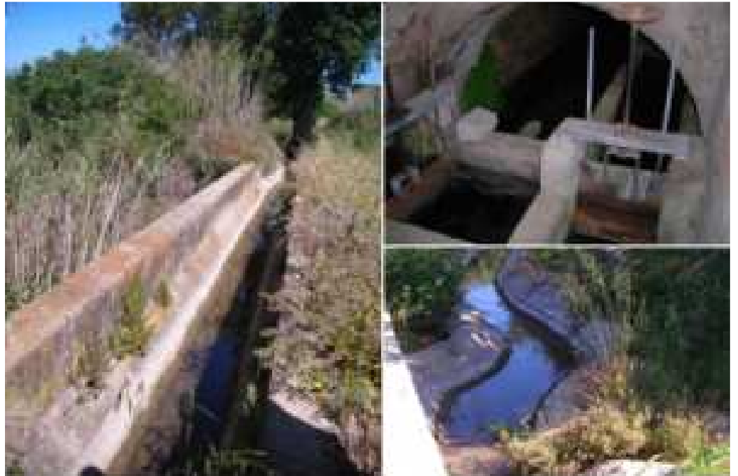
Figura 3.78: el Pont de les Caixes és una construcció medieval que substitueix un aqüeducte romà de la vil·la de Centelles. En l'actualitat encara fa la seva funció de dur aigua a les hortes de Constantí.
