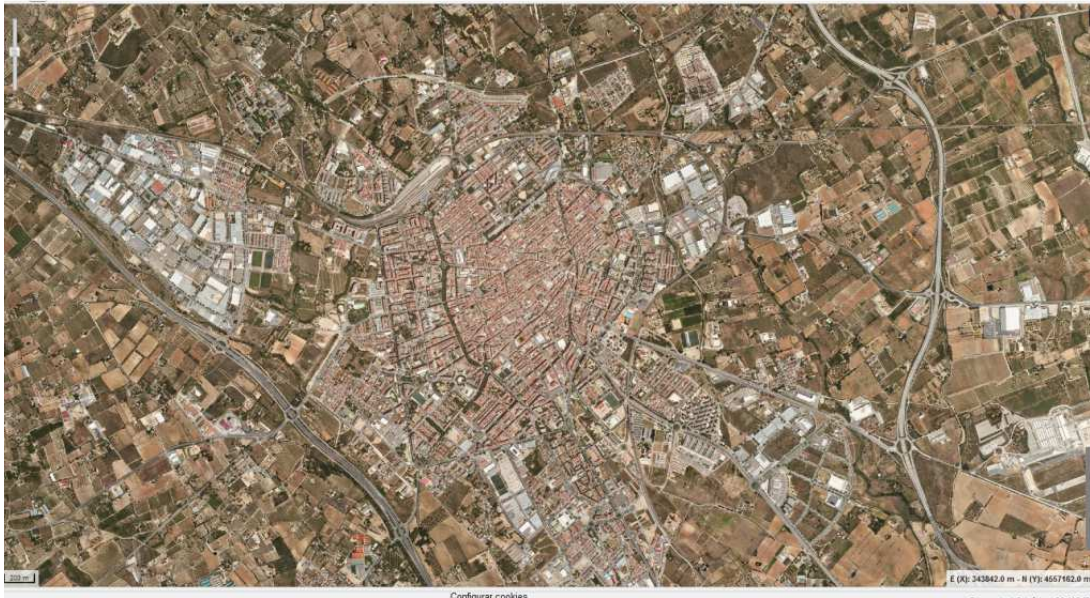
FIGURA 4.19: vista aèria de Reus, capital del Baix Camp (base IGCC).
