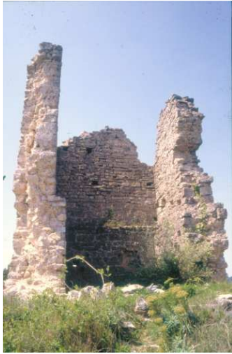
Figura 3.39: torre construïda amb la tècnica de la tabiya al castell de l'Albiol (Alt Camp). Si bé s'havia pres com una construcció feudal, la tècnica constructiva és molt similar a la del hisn de Siurana, per la qual cosa es proposa aquesta cronologia. Any 1993.
