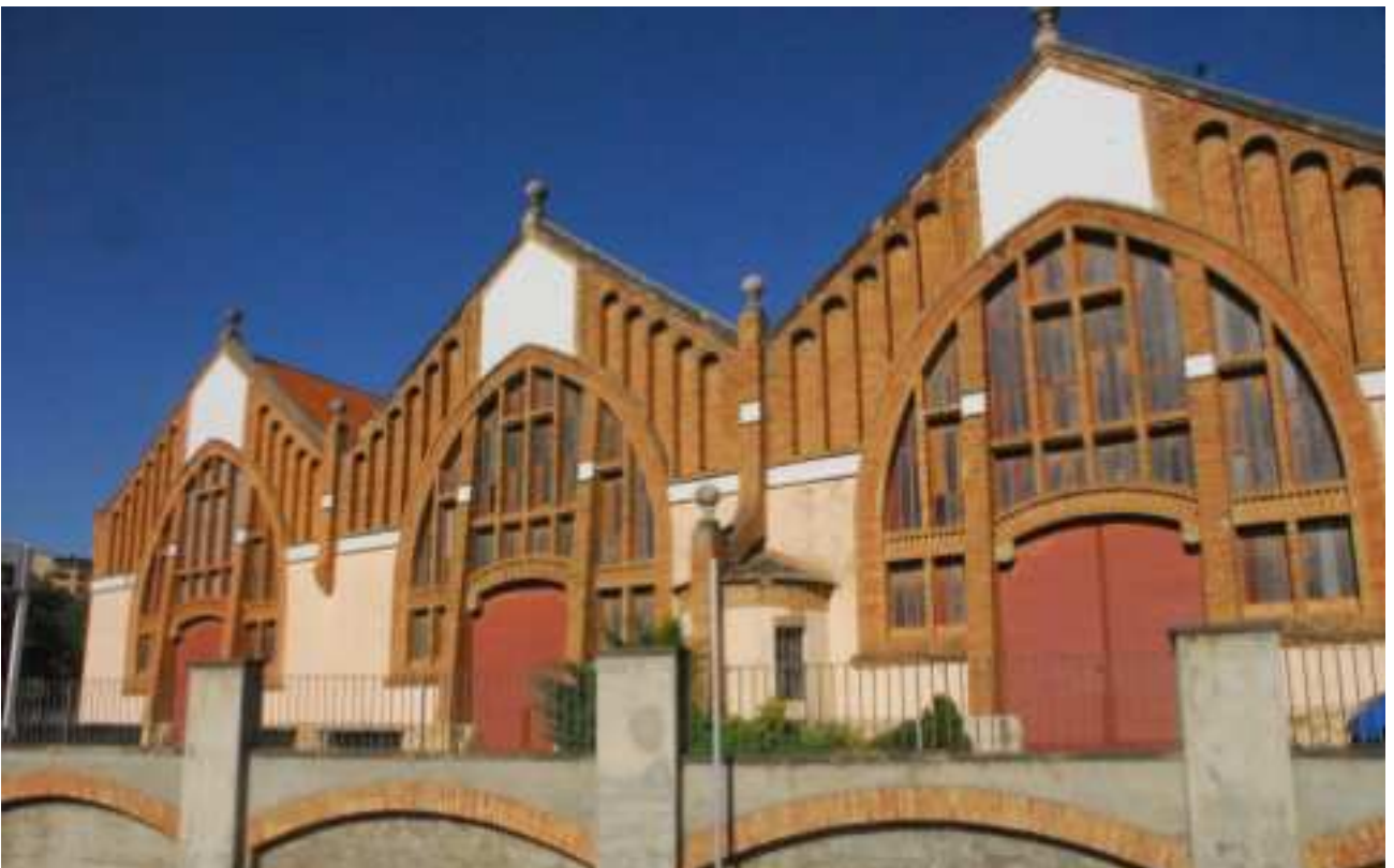
FIGURA 4.40: celler cooperatiu de l'Espluga de Francolí, obra dels arquitectes modernistes Lluís Domènech i Montaner i el seu fill Pere Domènech Roura. Se'l considera el celler insígnia de les anomenades catedrals del vi del Catalunya.
