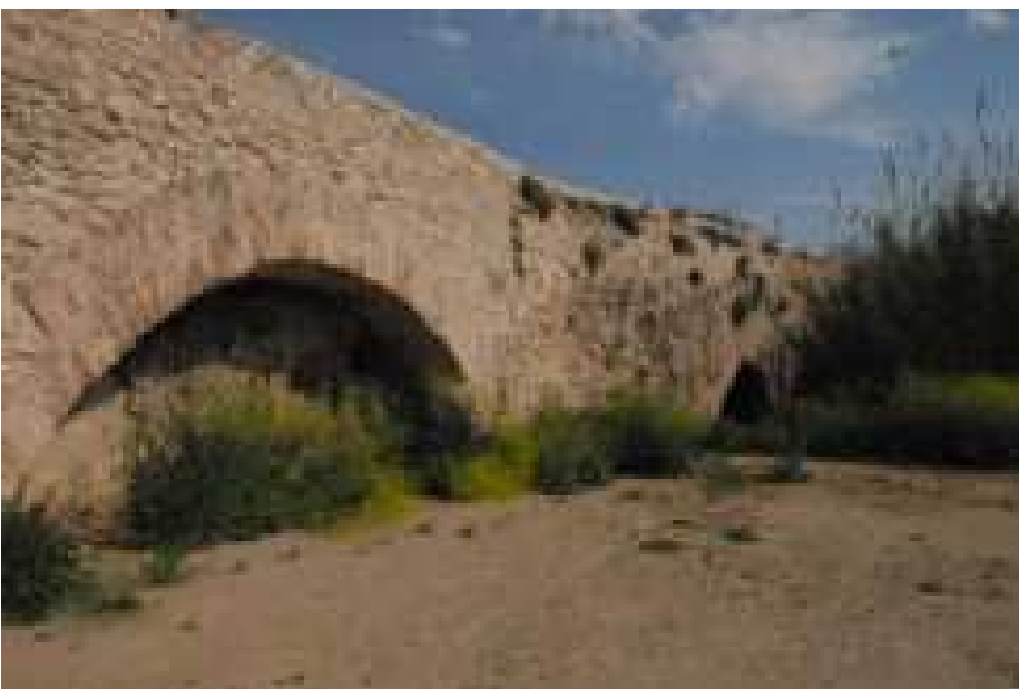
Figura 3.78: el Pont de les Caixes és una construcció medieval que substitueix un aqüeducte romà de la vil·la de Centelles. En l'actualitat encara fa la seva funció de dur aigua a les hortes de Constantí.
